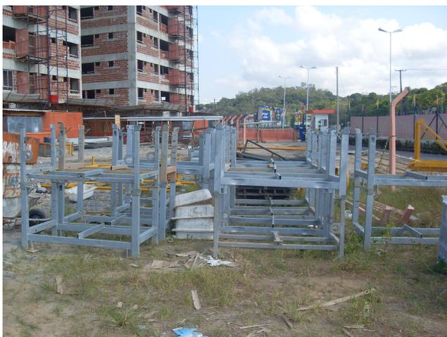
Figura 46 - Gaveteiro para armazenamento de escoras metálicas. Fonte: Jorge Souza
