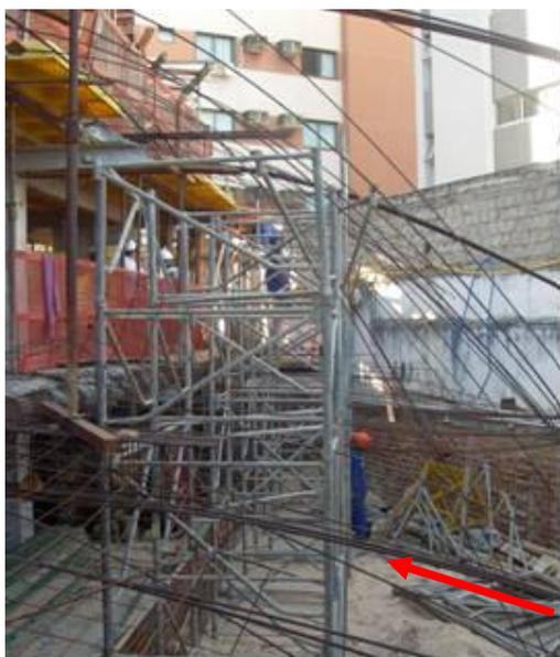
Figura 44 - Torres de escoramento montadas em apoio de terreno natural (arenoso). Fonte: Jorge Souza
