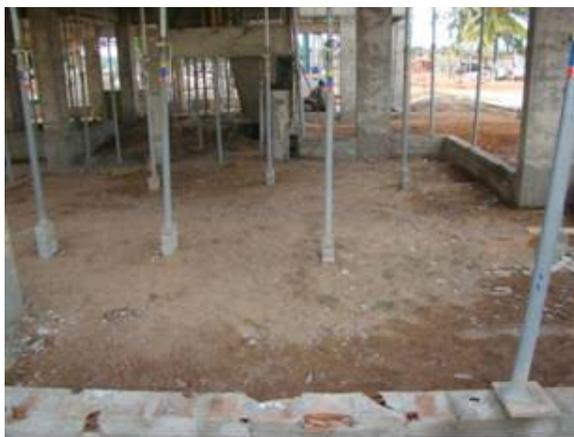
Figura 77 - Alvenaria de contenção – aterro do caixão. Fonte: Jorge Souza
