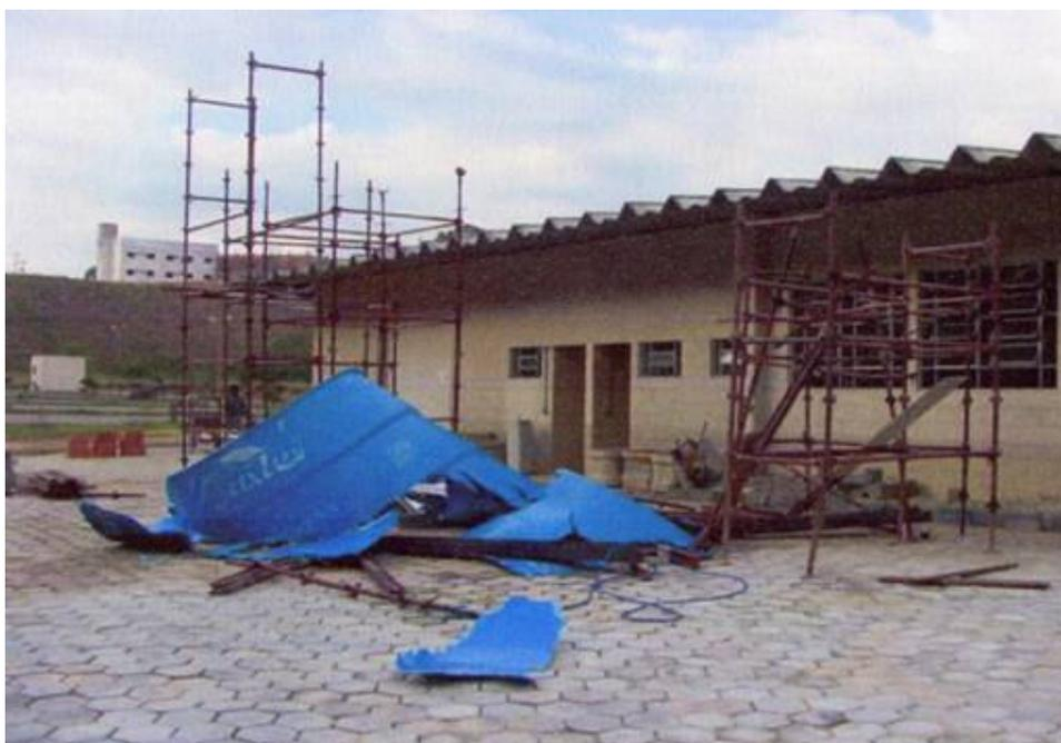
Figura 19 - Colapso de torre metálica. Fonte: Batista e Mascia (2006a)
