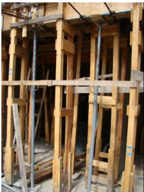
Figura 70 - Proporção de utilização de madeira em fundo de viga. Fonte: Jorge Souza
