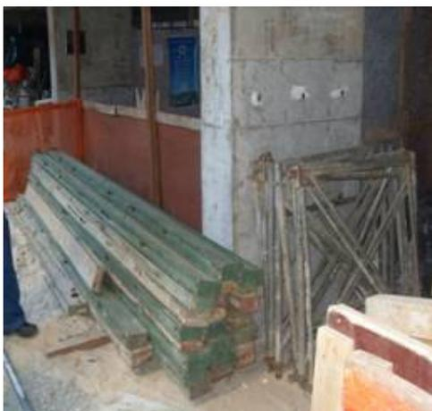
Figura 43 - Material armazenado sem critério de distinção. Fonte: Jorge Souza
