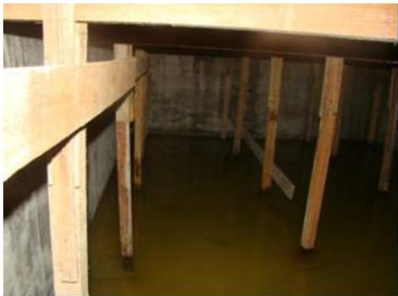
Figura 72 - Escoramento da laje de tampa do reservatório inferior. Fonte: Jorge Souza
