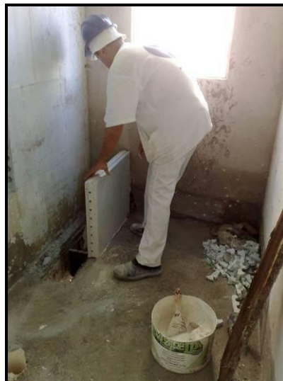
Figura 60 – Assentamento do bloco de gesso
