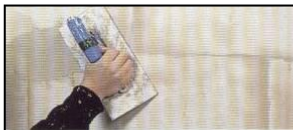
Figura 83 – Execução do acabamento final da vedação (ATUAL, 2009)
