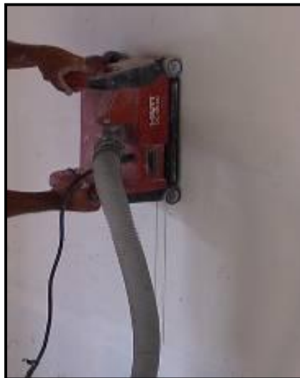
Figura 37 – Equipamento elétrico para realização de ranhura da vedação (ATUAL, 2009)
