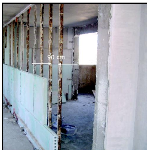
Figura 75 – Régulas metálicas separadas por 90 cm (ISOMUR, 2007)
