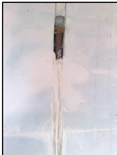
Figura 64 – Corte da parede com equipamento específico para as instalações
