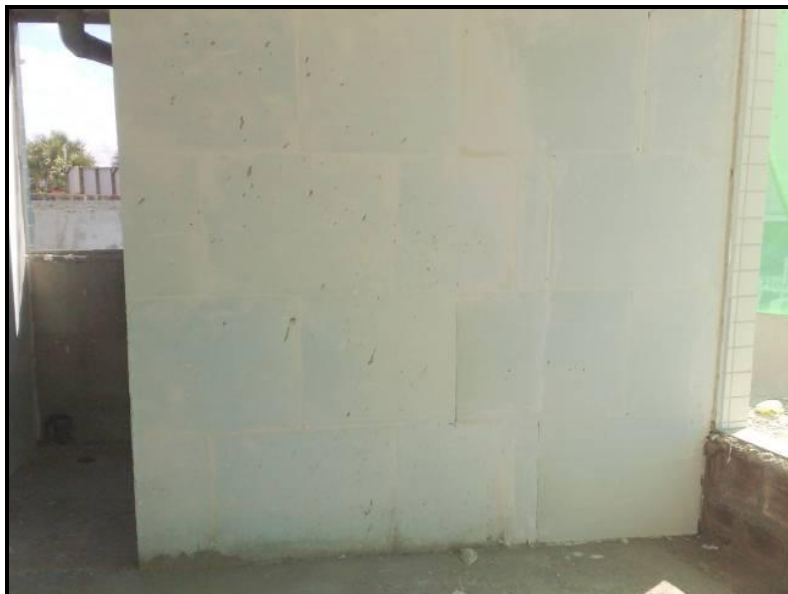
Figura 3 – Vedação vertical com blocos de gesso
