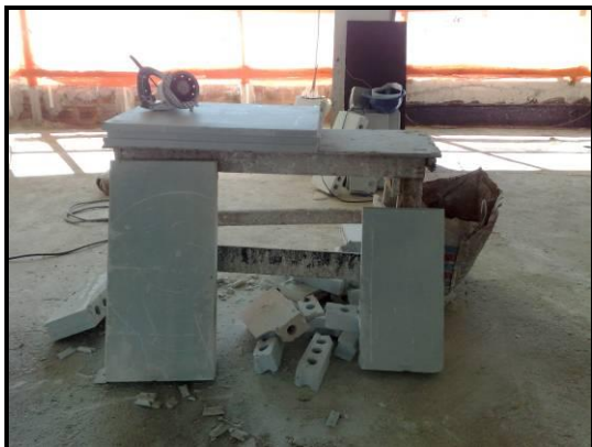
Figura 55 – Central de preparação dos blocos no próprio pavimento
