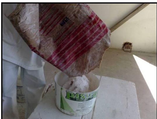
Figura 57 – Inserção da cola de gesso no recipiente de mistura
