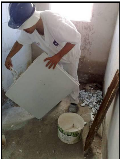
Figura 59 – Aplicação da cola de gesso com a espátula
