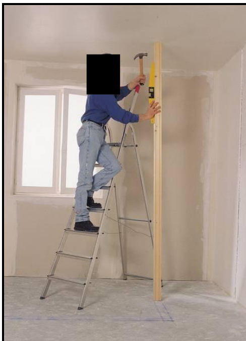
Figura 84 – Instalação dos elementos de reforço (DECOR, 2009)
