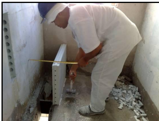
Figura 61 – Conferência de medida com trena metálica
