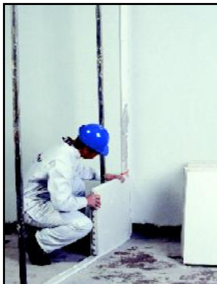
Figura 78 – Execução da primeira fiada com bloco hidrófugo (ISOMUR, 2007)
