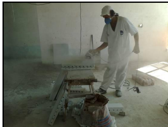
Figura 56 – Corte dos blocos de gesso com equipamento elétrico e poeira gerada
