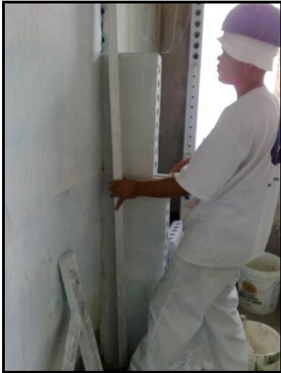
Figura 62 – Verificação do alinhamento com a régua de alumínio
