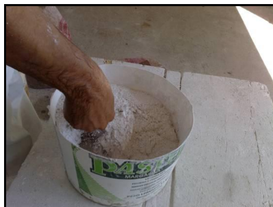
Figura 58 – Preparação da cola de gesso manualmente
