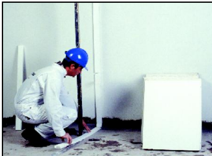
Figura 70 – Instalação dos elementos de dilatação (ISOMUR, 2007)
