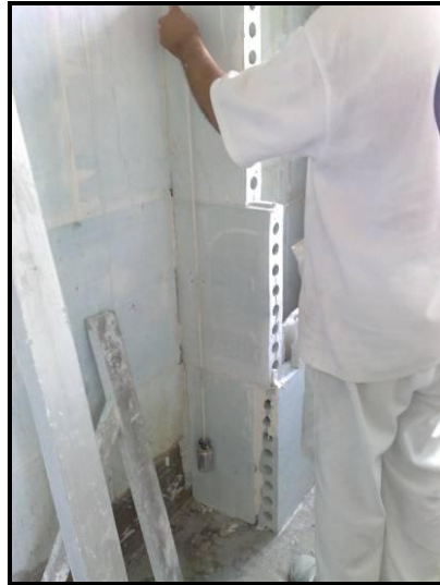
Figura 63 – Verificação do prumo com o fio de face
