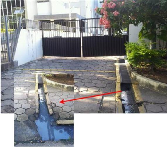
Figura 22 - Presença de esgoto na rede de drenagem.
