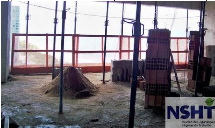
Figura 27 – Pavimento de edificação com vias livres e desimpedidas
