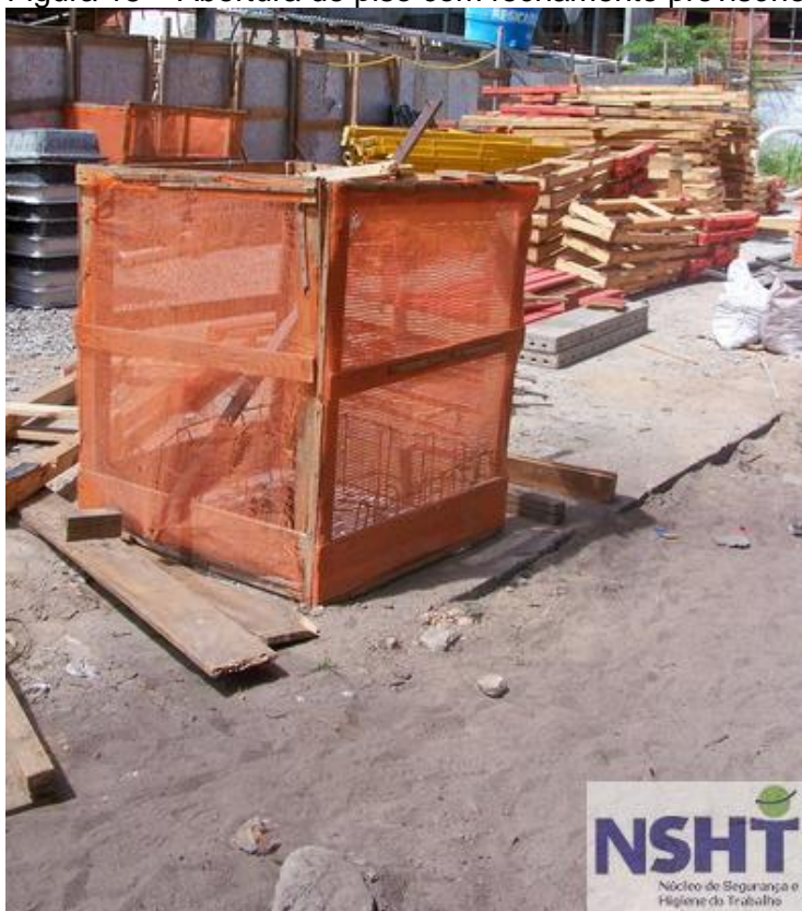
Figura 15 – Abertura de piso com fechamento provisório
