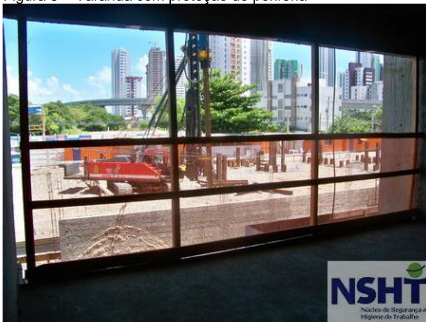
Figura 8 – Varanda com proteção de periferia
