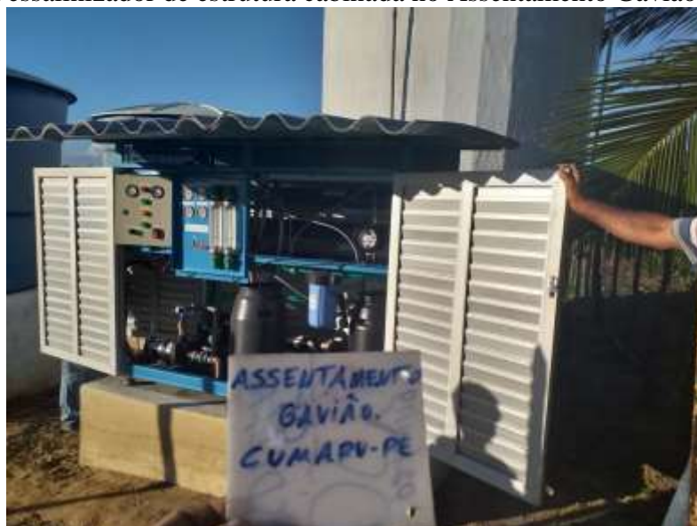
Figura 31 - Dessalinizador de estrutura cabinada no Assentamento Gavião - Cumaru/PE.
