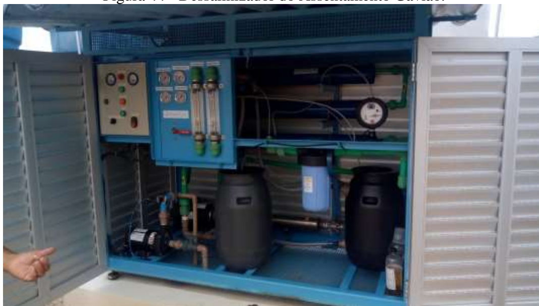
Figura 44 - Dessalinizador do Assentamento Gavião.
