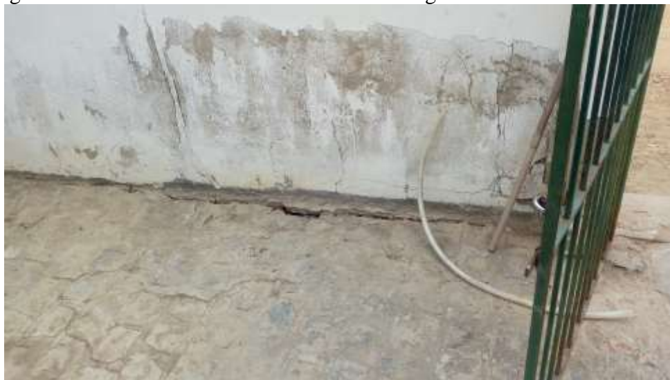
Figura 43 - Detalhe do muro de alvenaria do abrigo do Sítio Gavião 1 rachado.
