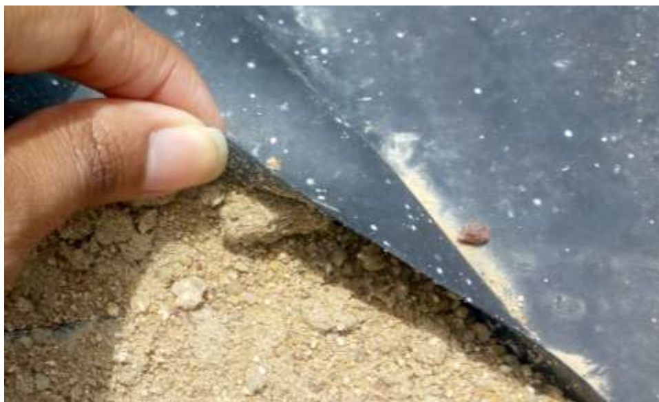
Figura 39 - Detalhe da manta de PVC que faz a cobertura dos tanques de concentrado.
