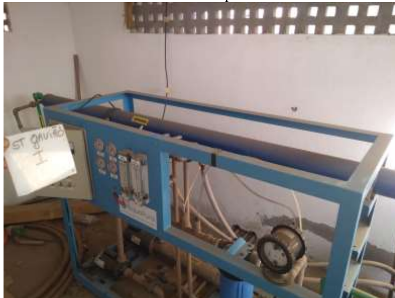
Figura 30 - Dessalinizador de estrutura simples no Sítio Gavião I - Cumaru/PE.
