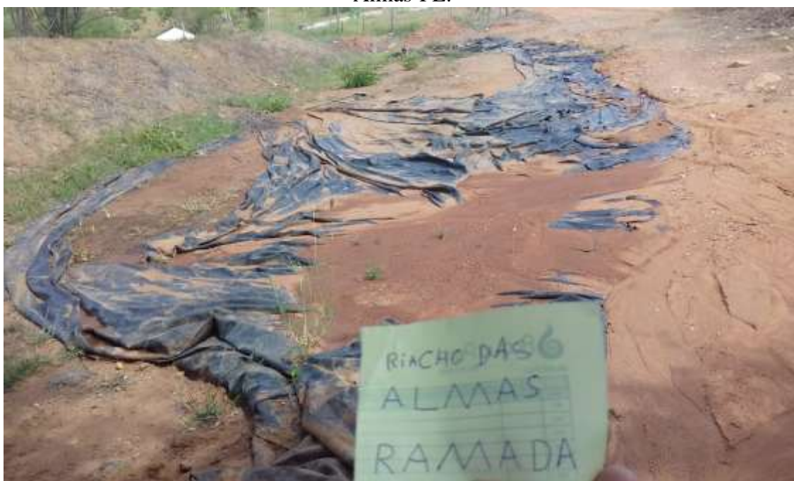
Figura 38 - Tanque de água salina em más condições no Sítio Ramada, em Riacho das Almas-PE.
