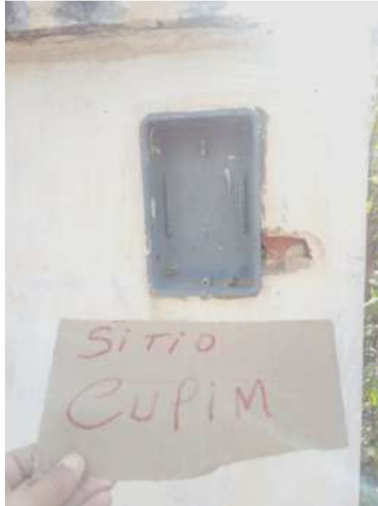
Figura 27 - Quadro de energia, sem ligação, no Sítio Cupim - Ouricuri/PE.
