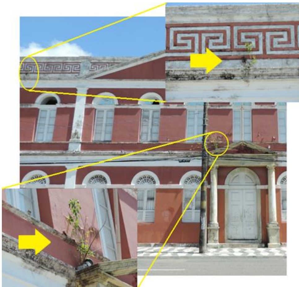
Figura 49 – Pontos com vegetação, fachada leste do GP
