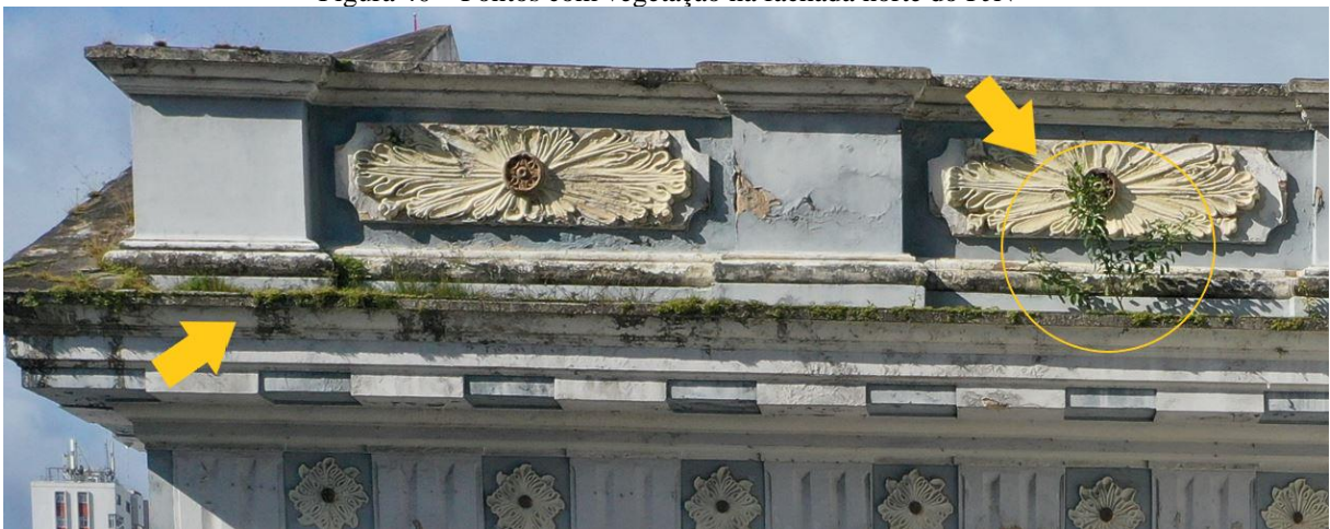
Figura 40 – Pontos com vegetação na fachada norte do PjN
