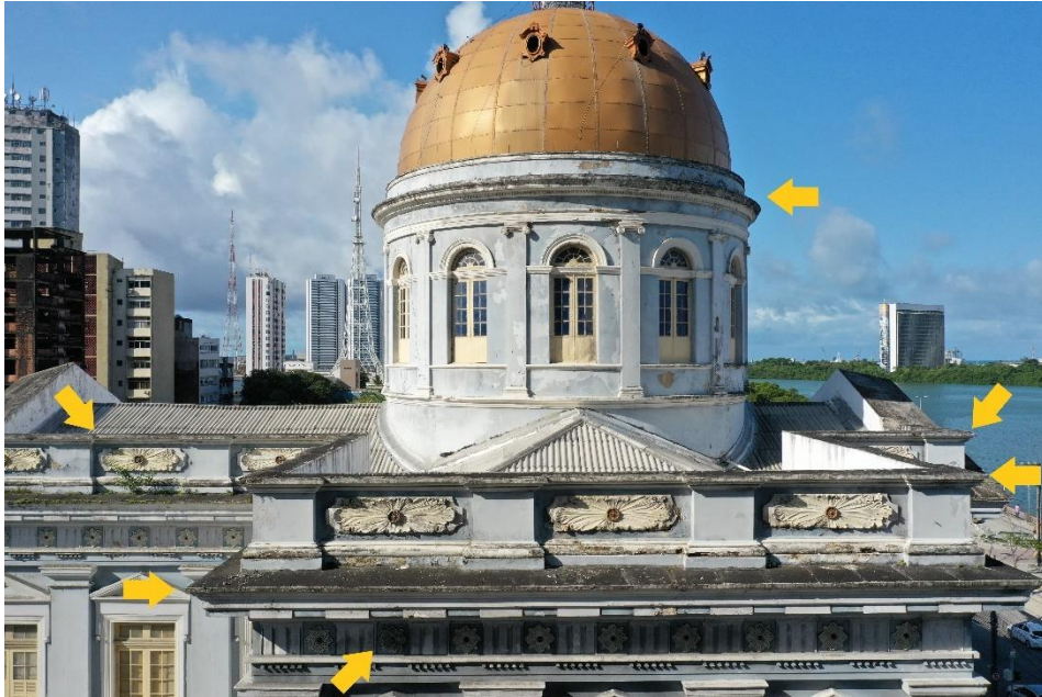
Figura 36 – Pontos de sujidade em cimalkhas, friso e arquitrave, fachada norte do PJN
