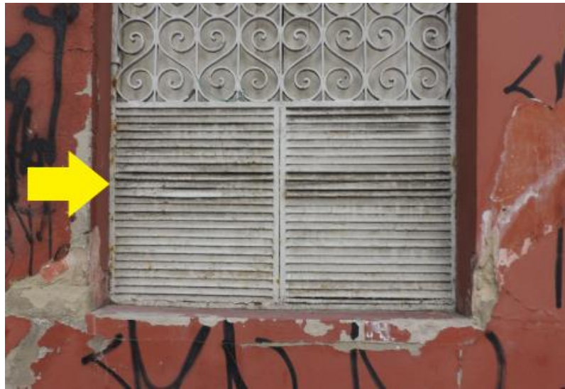
Figura 57 – Sujidades em grade de janela do GP
