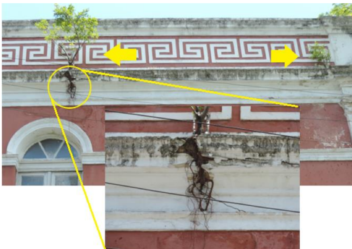
Figura 77 – Vegetação na fachada norte do GP
