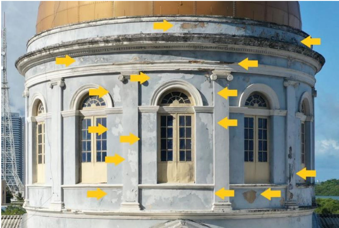
Figura 38 – Destacamentos de pintura e destacamentos de reboco na cúpula, fachada norte do PJN
