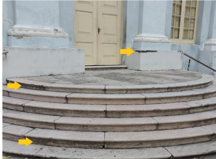
Figura 23 – Pontos de sujidade, parte da fachada posterior do PJJ
