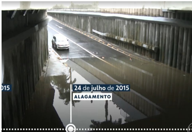
Figura 51 - Alagamento do dia 24 de julho de 2015 no Túnel da Abolição
