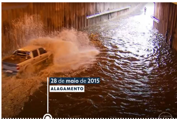
Figura 49 - Alagamento durante a Construção do Túnel da Abolição
