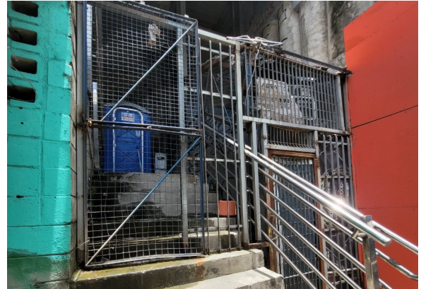
Figura 19 – Escadaria de acesso para a Praça
