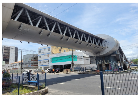
Figura 15 – Passarela para travessia do Túnel Josué de Castro
