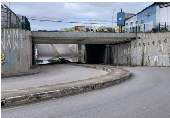
Figura 16 – Estruturas do Túnel Felipe Camarão
