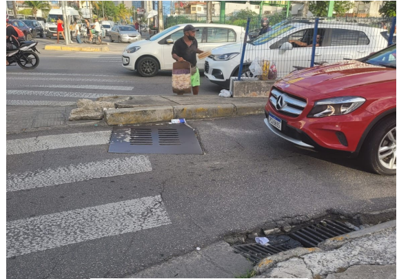
Figura 35 - Rua Manoel Brito com suas duas captações
