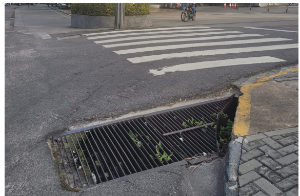
Figura 33 – Único dispositivo de captação da Rua Nogueira de Souza
