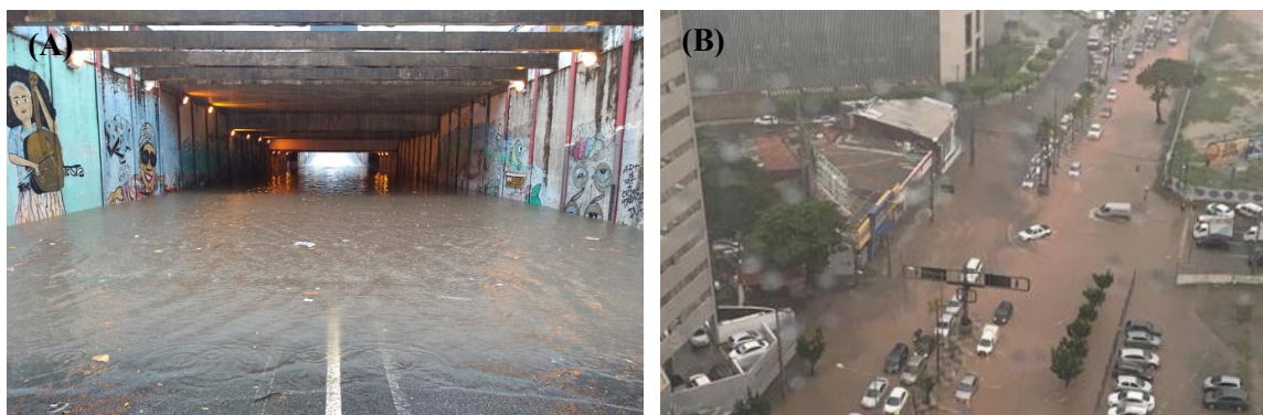
Figura 5 – Alagamento do Túnel Josué de Castro devido à precipitação de 13/06/2019: (A) imagem do interior do Túnel; (B) Imagem da sua saída para a Av. Antônio de Góes
