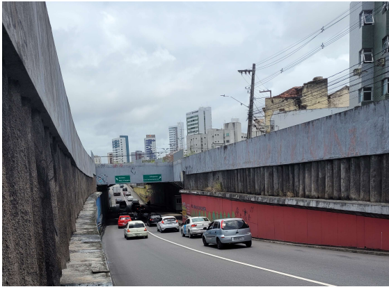
Figura 18 – Estruturas do Túnel da Abolição
