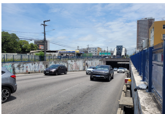
Figura 14 – Estruturas do Túnel Josué de Castro
