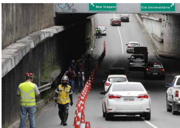
Figura 55 – Faixa interditada para requalificação das paredes do Túnel da Abolição
