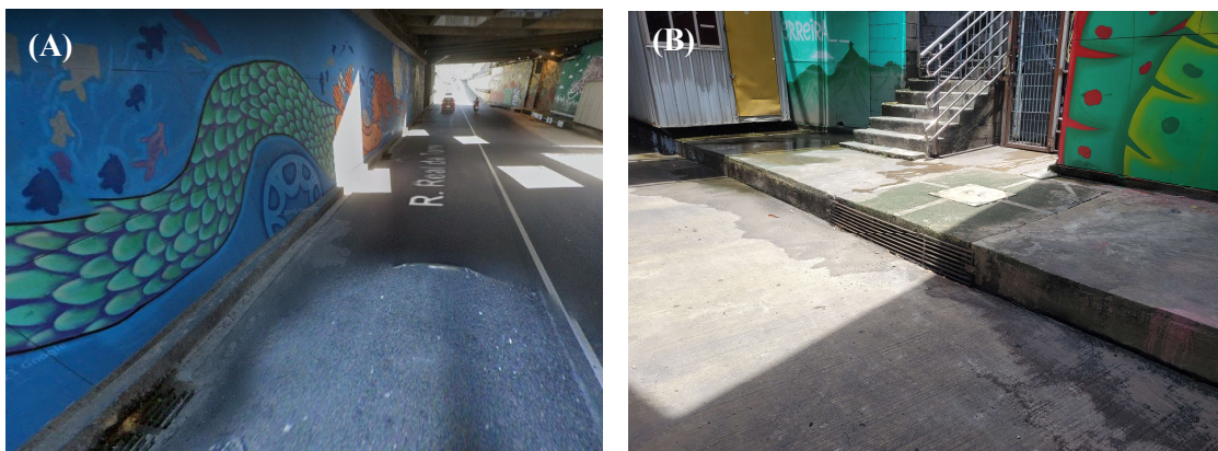
Figuras 47 - Pontos de captação de água no interior do Túnel da Abolição lado esquerdo (A) e direito (B)
