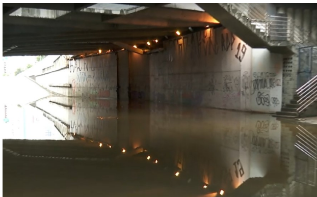
Figura 57 - Alagamento no Túnel da Abolição ocorrido no dia 13/06/2019
