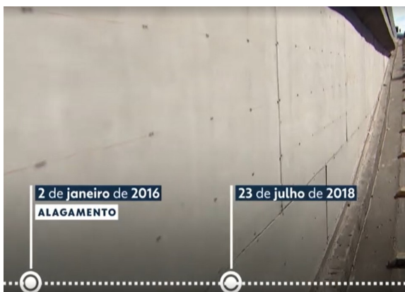
Figura 53 - Obras de recuperação para controle das infiltrações
