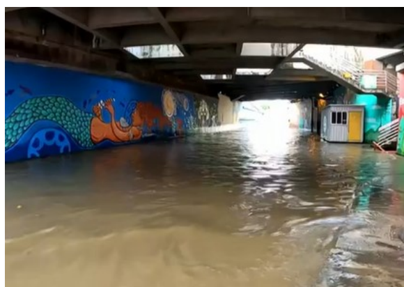
Figura 56 - Alagamento do dia 14 de janeiro de 2022 no Túnel da Abolição
