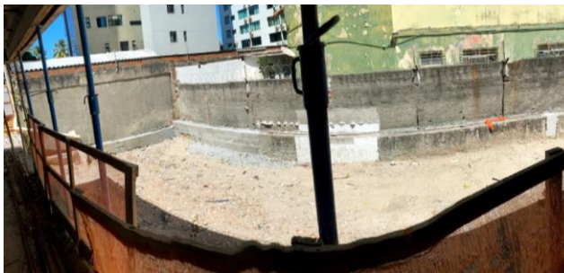
Figura 55 - Aterro utilizando resíduos de concreto.
