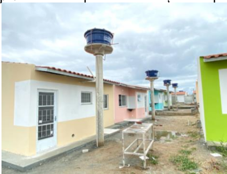
Figura 68 - Materiais pré-moldados para a construção dos pilares das caixas d'água.
