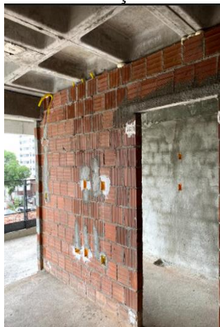
Figura 75 - Alvenaria racionalizada com blocos na vertical no local destinado a passagem das tubulações.
