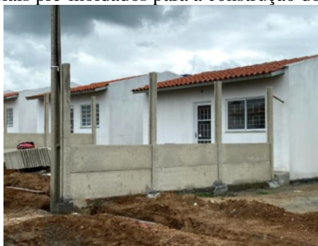
Figura 67 - Materiais pré-moldados para a construção dos muros das casas.
