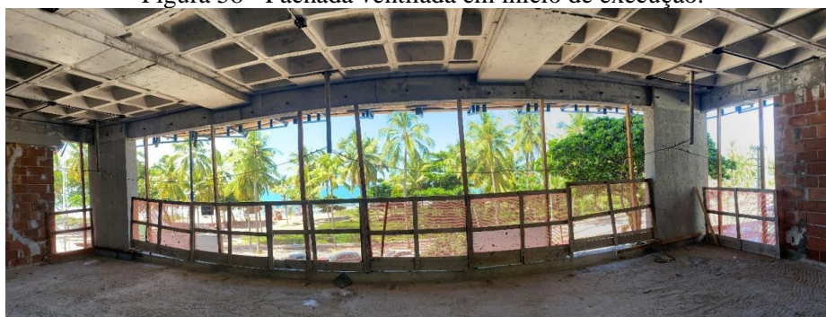
Figura 58 - Fachada ventilada em início de execução.
