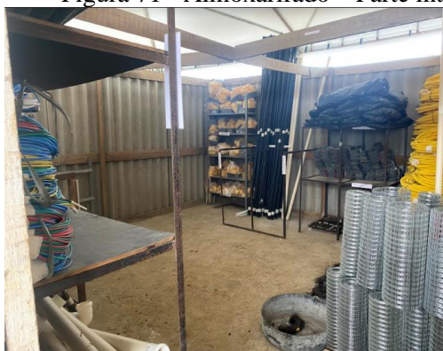
Figura 71 - Almojarifado – Parte interna
