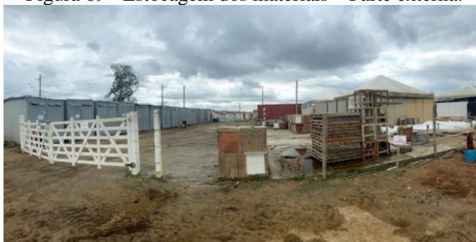
Figura 69 - Estocagem dos materiais – Parte externa.
