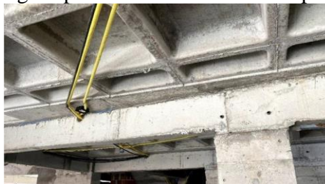
Figura 56 - Passagens pré-definidas durante a etapa de concretagem.
