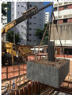
Figura 61 - Chegada de um elemento da fundação superficial do empreendimento, montada em galpão com o uso de fôrma incorporada.
