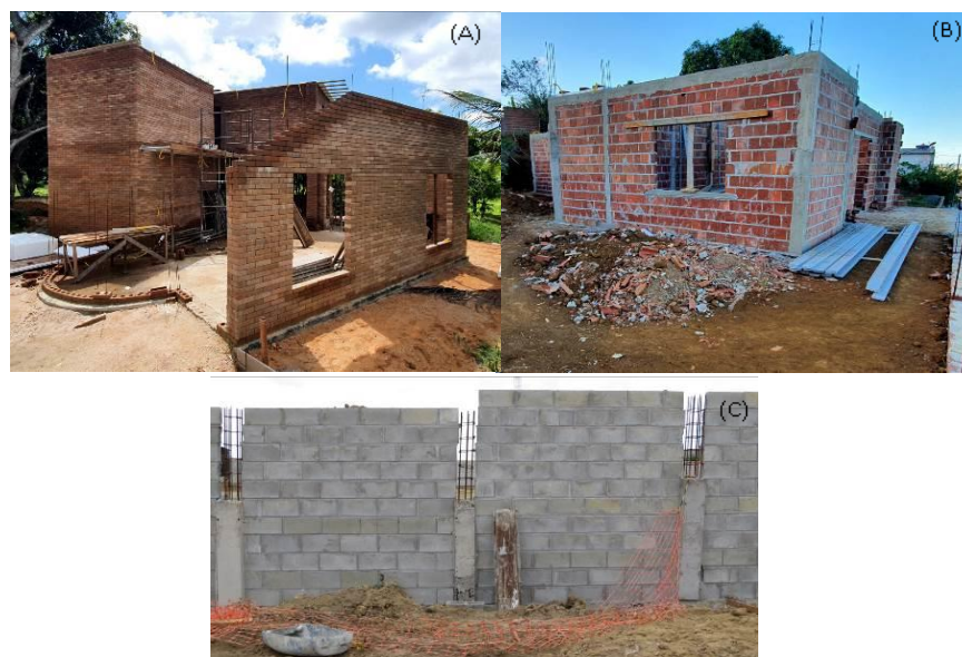
Figura 51 – Execução de obras: Tijolo de solo cimento (A), Tijolo cerâmico (B) e Bloco de concreto (C).
