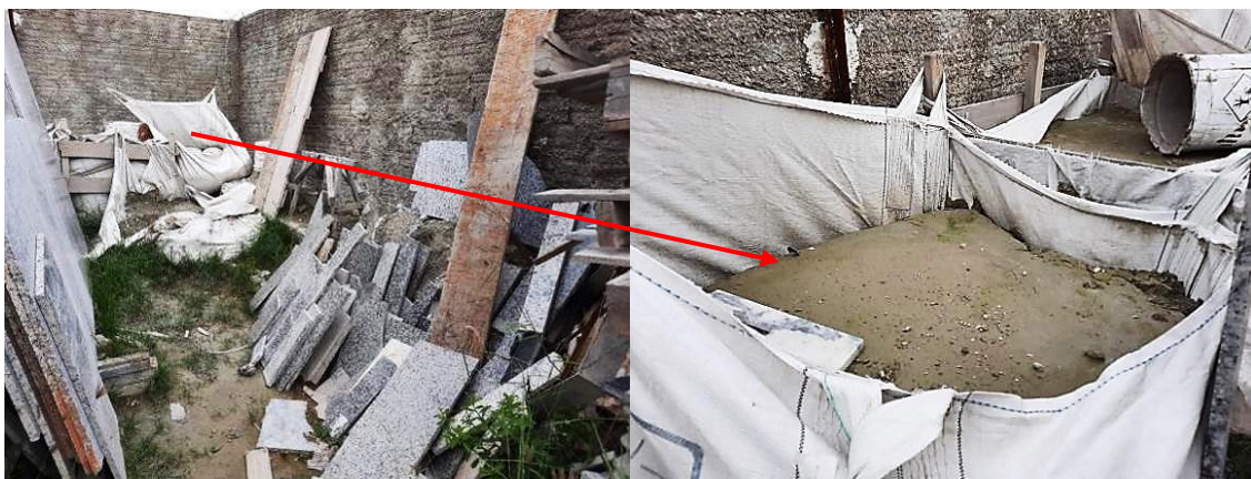
Figura 3- Resíduos dispostos para secagem.
