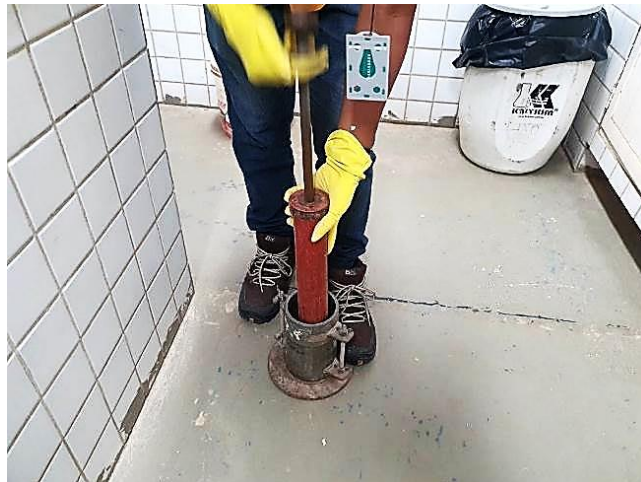
Figura 23 –Realização do ensaio de compactação
