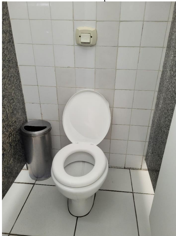
Figura 17 - Bacia com válvula simples - Vestiário Masculino
