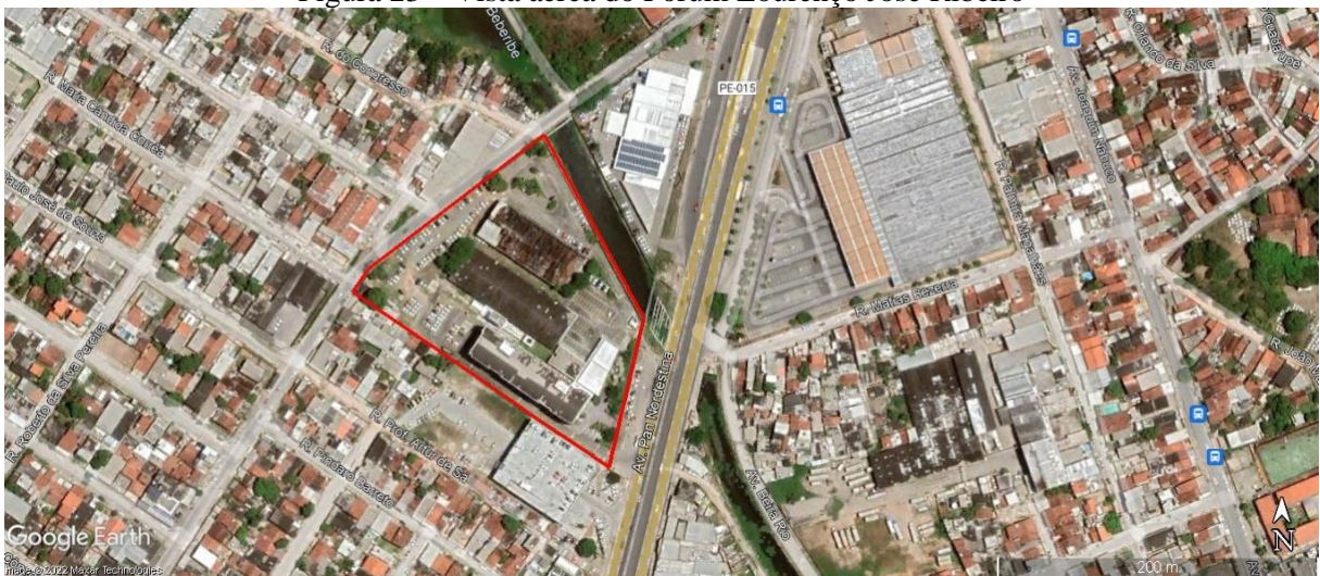
Figura 23 – Vista aérea do Fórum Lourenço José Ribeiro
