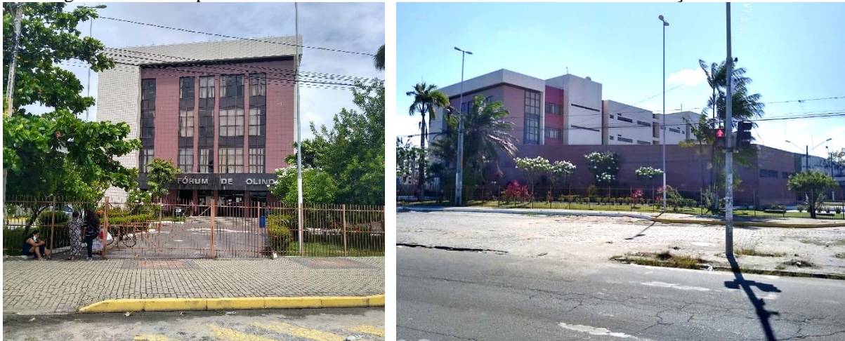
Figura 22 – Vista parcial das fachadas Sudeste e Nordeste do Fórum Lourenço José Ribeiro
