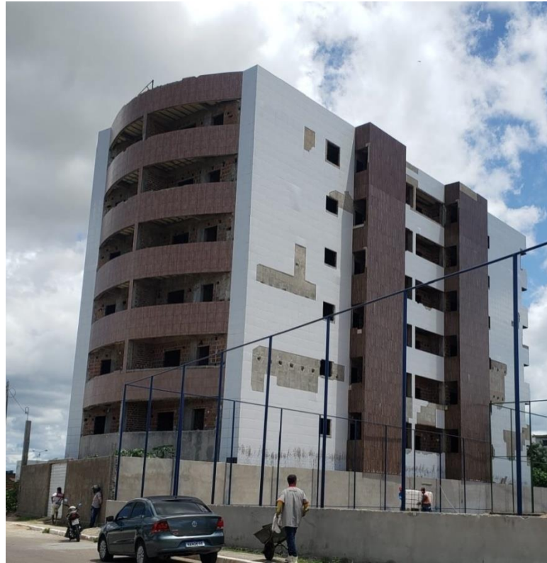
Figura 23 – Fachada leste (lateral).
