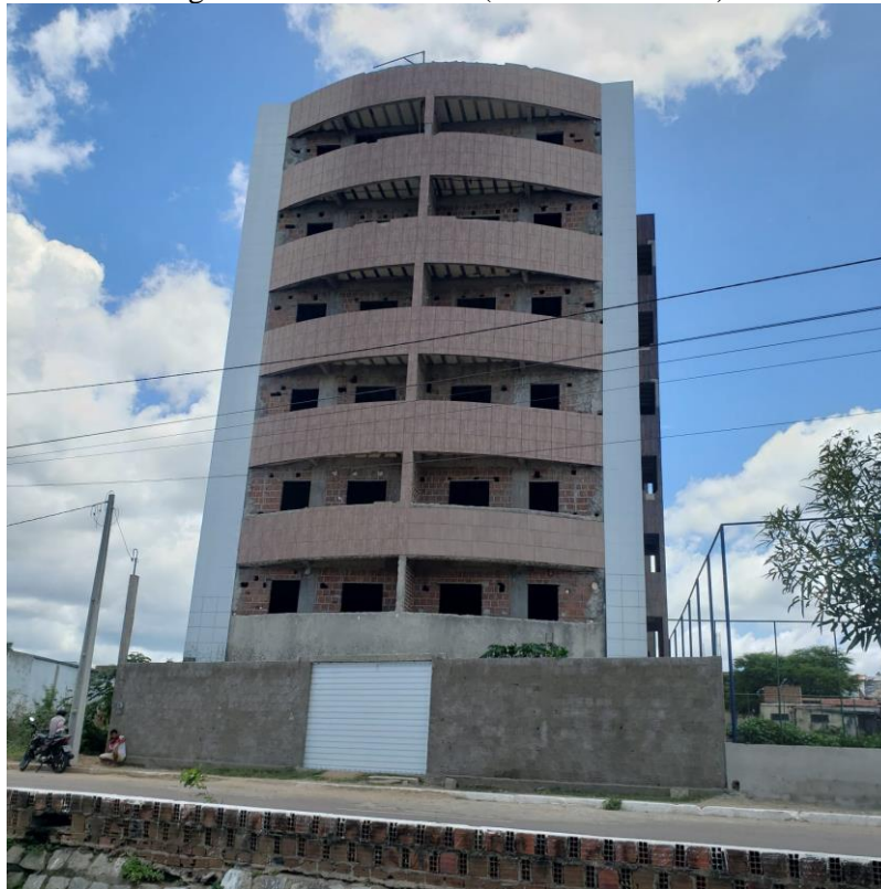
Figura 21 – Fachada sul (frente do edifício).
