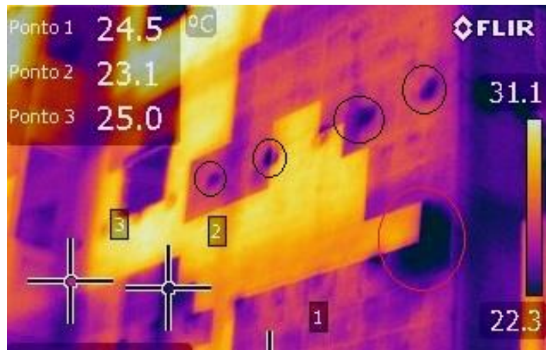
Figura 39 – Imagem termográfica da fachada oeste
