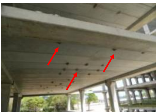
(C) Parte inferior das lajes onde estão os dispositivos para nivelamento dos painéis.
