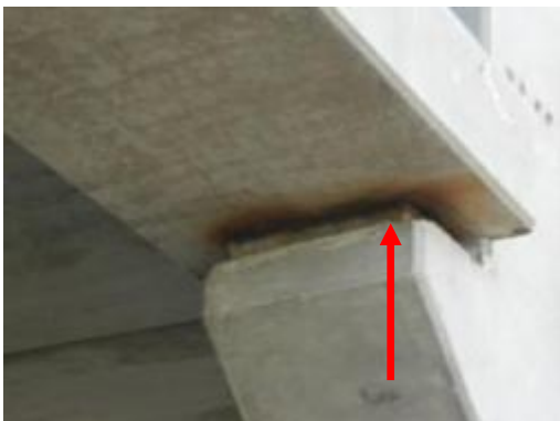
(D) Chapa para consolidação da viga com o pilar.
