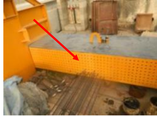
(B) Macaco para a protensão dos cabos de aço.
