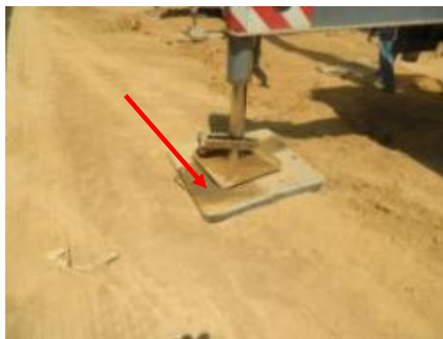
(B) Plataforma de neoprene para o patolamento do guindastes.
