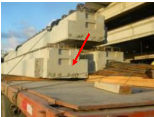
(C) Carregamento de vigas na carreta
