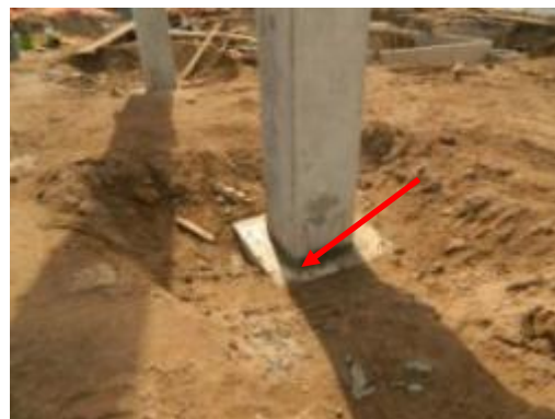
(F) Fixação concluída. Pilar grauteado
