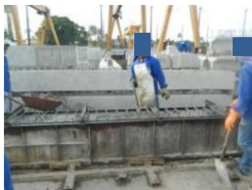
(F) Adensamento do concreto.
