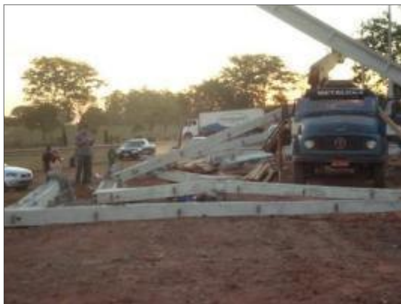
Figura 2 - Desabamento de galpão em construção em Cuiabá - MT Autor: Olhardireto (2012)
