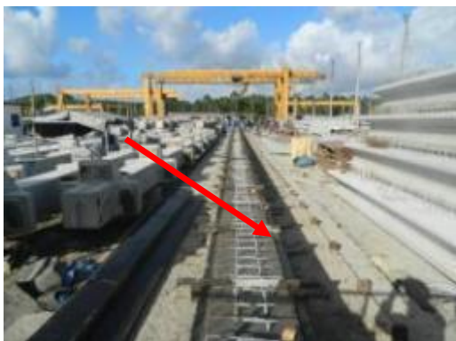
(C) Vigas concretadas na pista
