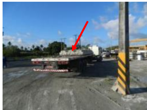
(D) Transporte de vigas para a obra
