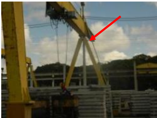
(A) Laje sendo armazenada no pátio de estocagem
