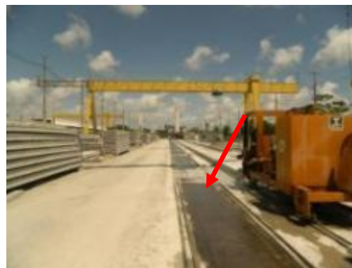
(B) Aplicação de desmoldante na pista.
