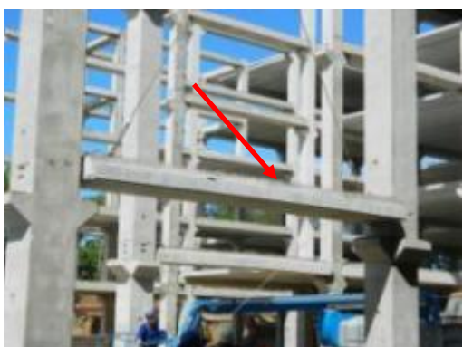
(D) Viga sendo apoiada os entre consoles dos pilares.
