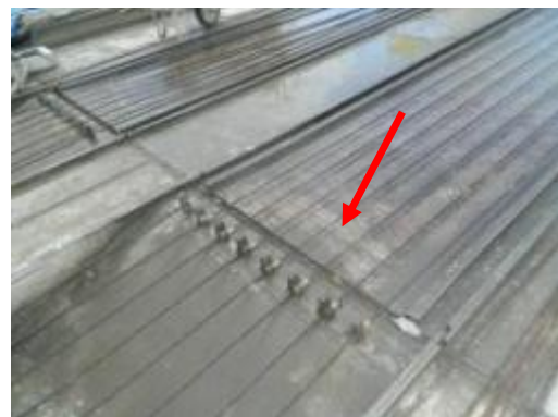
(B) Cordoalhas lançadas na pista.
