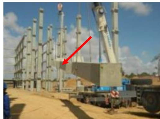
(B) Içamento do pilar.
