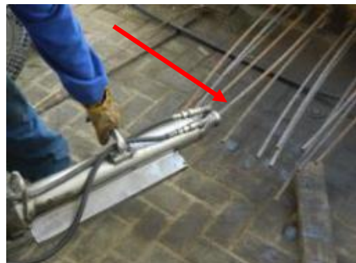
(D) Preparação para a protensão com equipamento manual
