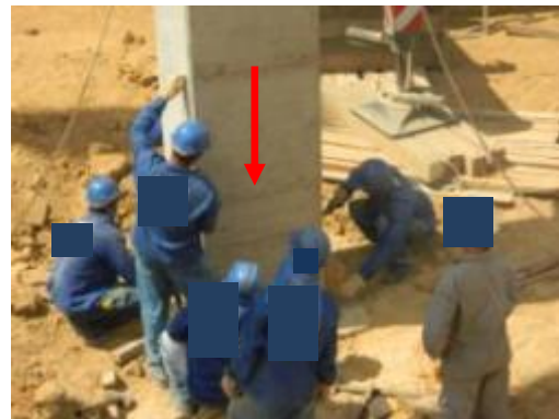
(B) Verificação do prumo
