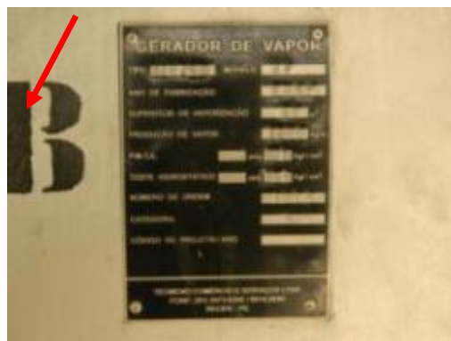
(F) Placa de identificação da caldeira (Categoria B).
