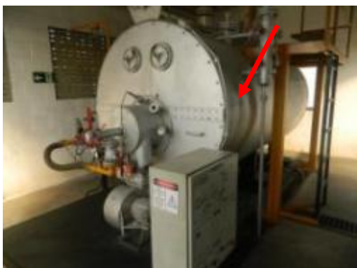
(E) Caldeira utilizada para geração de vapor utilizado na cura das lajes.
