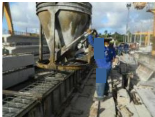
(D) Lançamento manual do concreto na forma.
