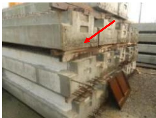
(B) Vigas na estocagem para corte da sobra dos ferros da proteção.
