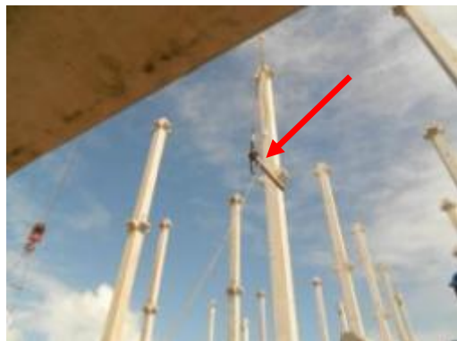
(D) Retirada do pino de içagem com auxílio de cordas.
