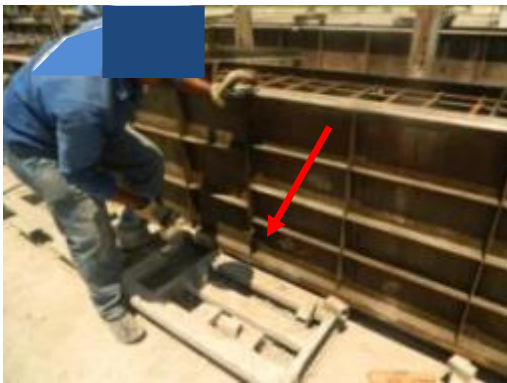
(D) Instalação da peça de fixação dos painéis laterais da forma
