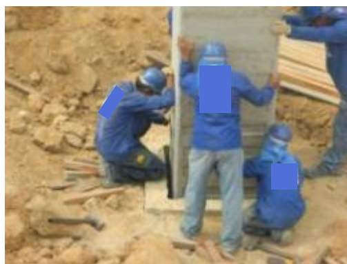
(H) Introdução do pilar no cálice da fundação
