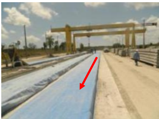
(A) Disposição de lona sobre a laje para a cura a vapor.
