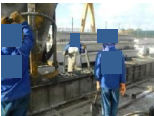
(E) Lançamento e adensamento do concreto.
