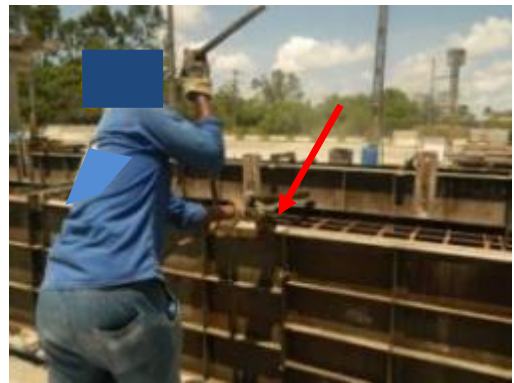
(E) Ferramenta (alavanca) usada para fixação da cantoneira do travamento da face superior da forma
