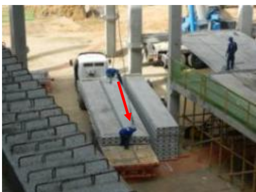
(E) Instalação da corda e do cabo para o içamento das lajes
