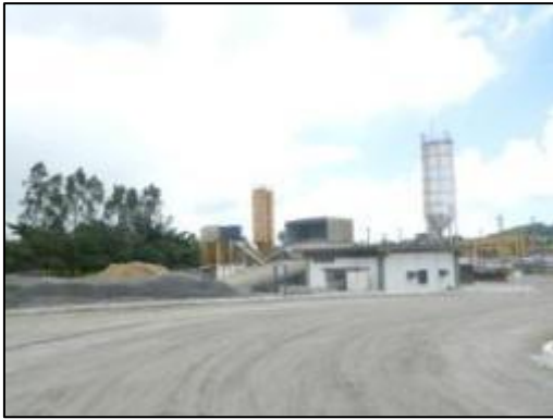
(A) Central de produção do concreto.
