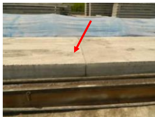
(D) Laje após o corte.
