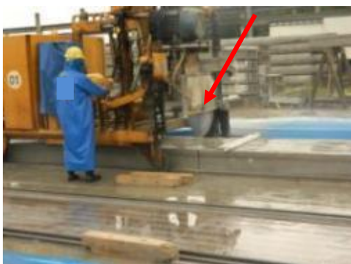
(C) Serra diamantada para cortes das lajes.
