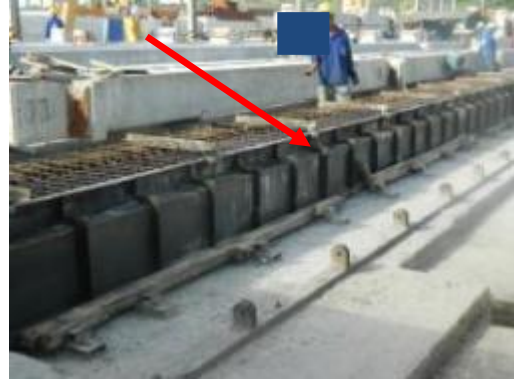
(B) Fechamento da forma das vigas.
