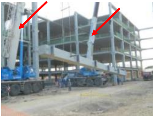
(A) Início da instalação de pilar utilizando dois guindastes.
