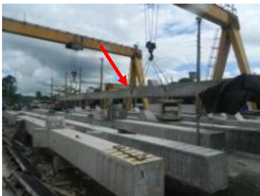
(C) Pilar sendo içado.
