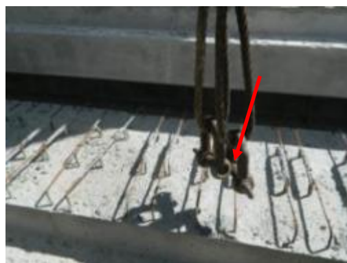
(B) Instalação de manilhas para içagem
