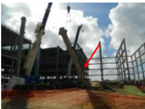
(E) Início da instalação de pilar.
