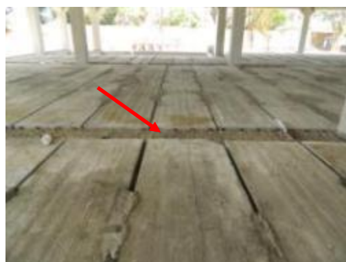
(D) Retirada dos “sargentos” após a cura do concreto colocado entre painéis de lajes
