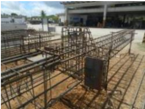
(A) Armação pronta para a instalação na forma.
