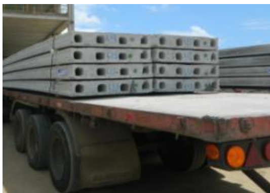
(C) Lajes no transporte para a obra
