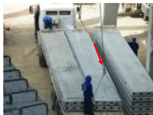
(F) Preparação para o içamento das lajes
