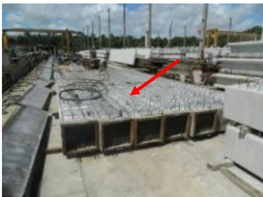
(A) Viga desmoldadas.
