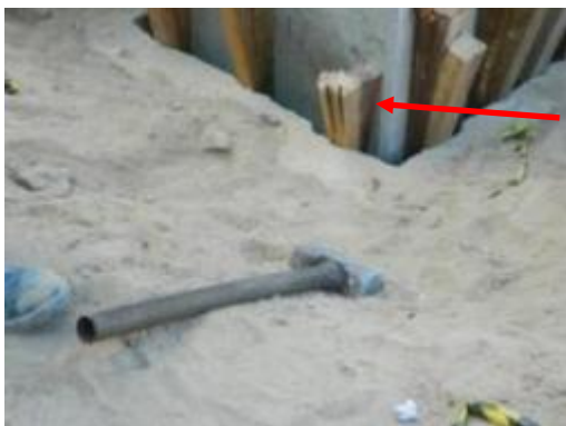
(E) Encunhamento do pilar
