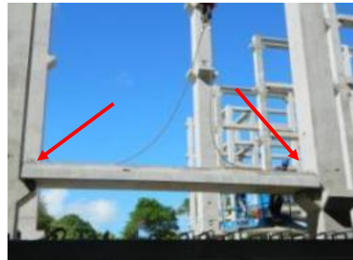
(B) Viga posicionada entre os consoles, com o auxílio do guindaste.
