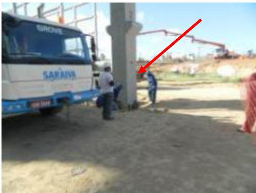
(A) Pilar instalado no cálice da fundação
