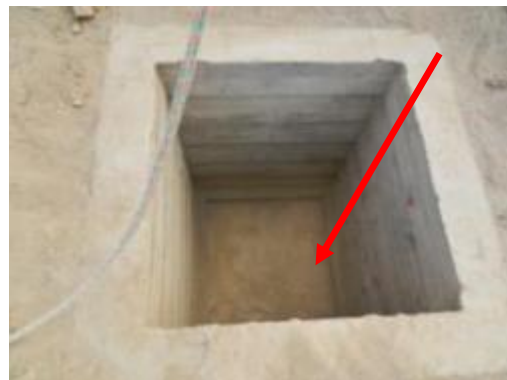
(B) Limpeza do cálice de fundação
