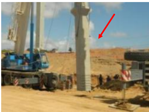
(C) Início da instalação de pilar.
