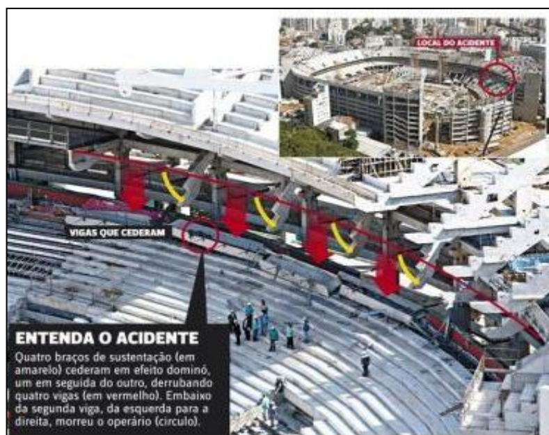
Figura 5 - Acidente no estádio do Palmeiras em SP Autor: G1 (2013)
