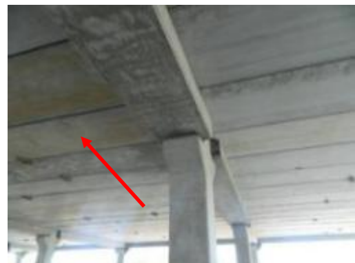
(D) Vista da parte inferior de lajes instaladas
