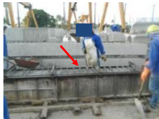
(B) Adensamento do concreto
