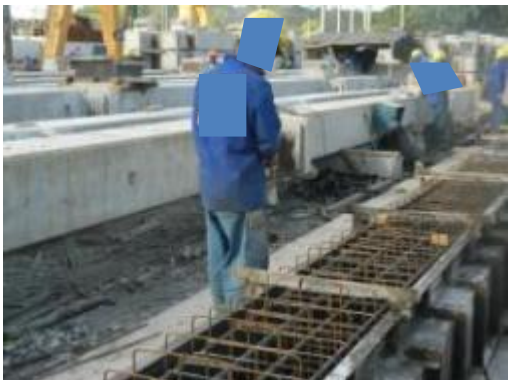
(C) Armação instalada no interior da forma
