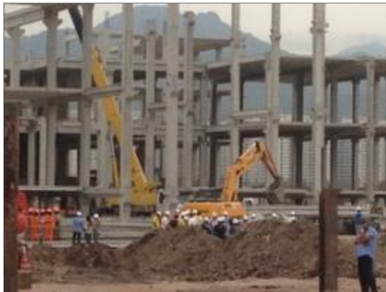
Figura 3 - Acidente na construção de um shopping no Rio de Janeiro.
