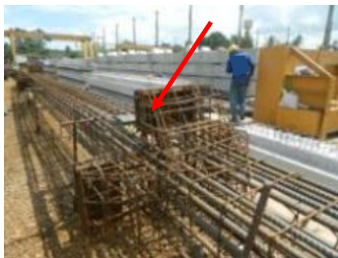
(F) Armação de pilares concluída
