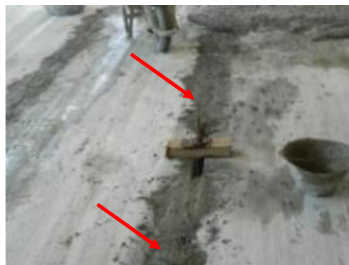
(D) Concretagem do espaço entre as lajes.
