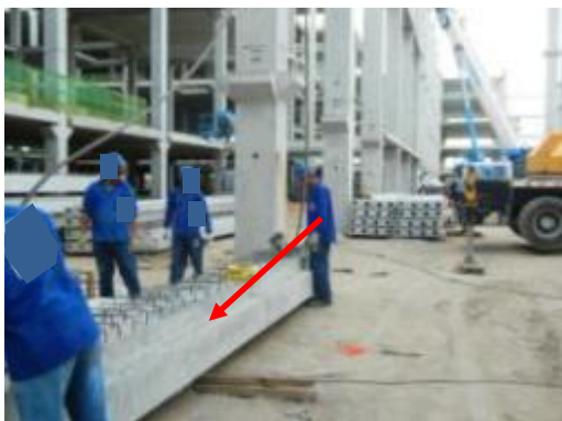
(A) Viga pronta para o içamento.
