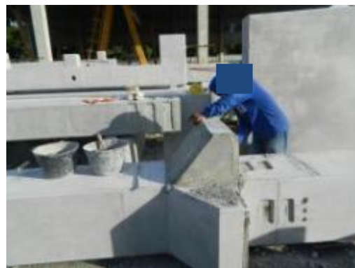
(B) Execução de acabamento dos consoles do pilar.
