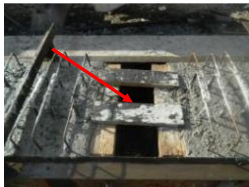
(D) Vão de separação das vigas
