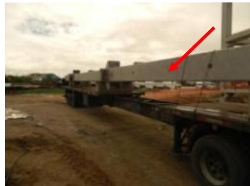
(D) Chegada de pilar de grande porte na obra, através de carreta extensiva.
