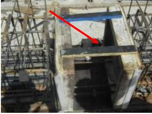
(A) Madeira para delimitação do tamanho das vigas.
