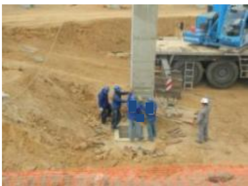
(G) Instalação de pilar no cálice.
