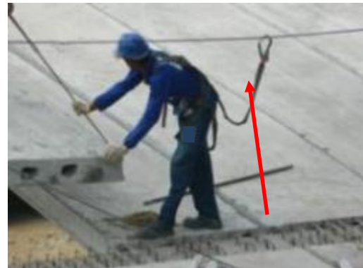
(B) Trabalhador ancorado à linha de vida enquanto posiciona a laje nas vigas.
