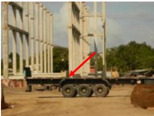
(E) Retorno da carreta após a entrega dos pilares na obra
