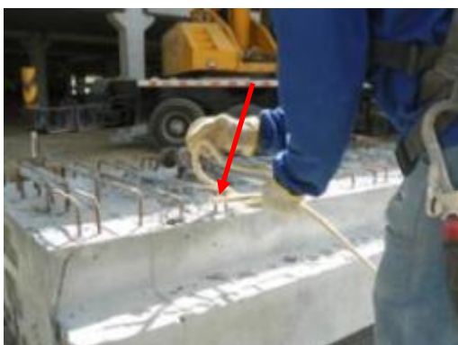
(A) Instalação de cordas para a guia da viga
