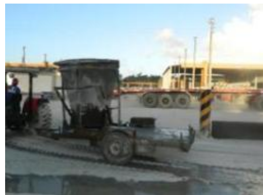
(B) Trator transportando o recipiente com o concreto.
