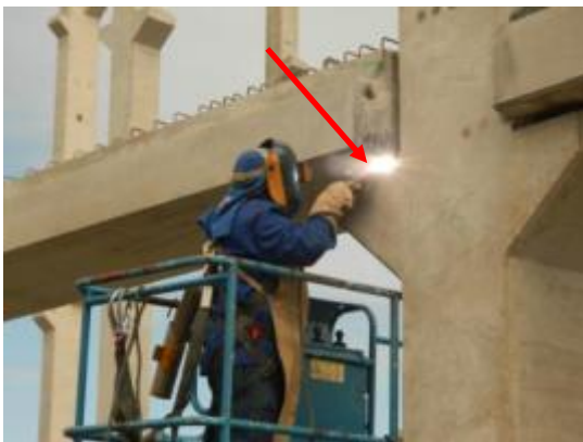
(A) Execução de solda para fixação da viga nos pilares.
