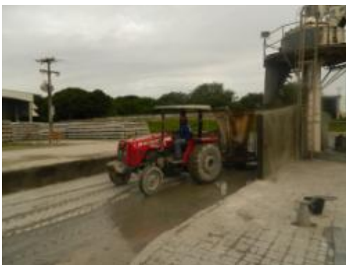
(A) Recebimento do concreto na central de produção.
