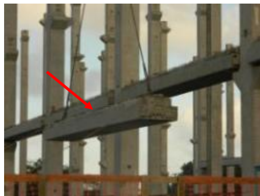
(B) Viga sendo içada para a instalação entre os pilares
