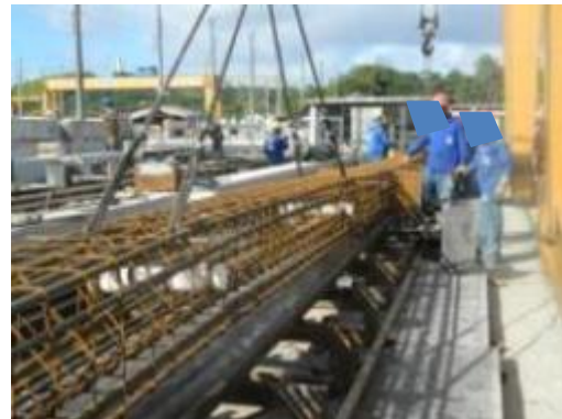
(B) Armação sendo içada para a instalação na forma.
