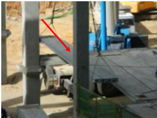
(A) Montagem de lajes entre as vigas.
