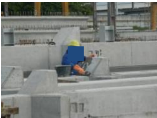
(A) Pilares no pátio de estocagem
