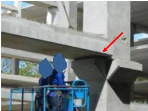
(A) Ajuste da viga com auxílios de alavancas
