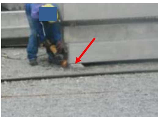
(C) Corte das sobras dos cabos da proteção, com policorte.
