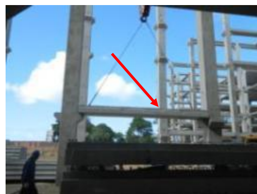
(E) Viga já apoiada entre os consoles dos pilares
