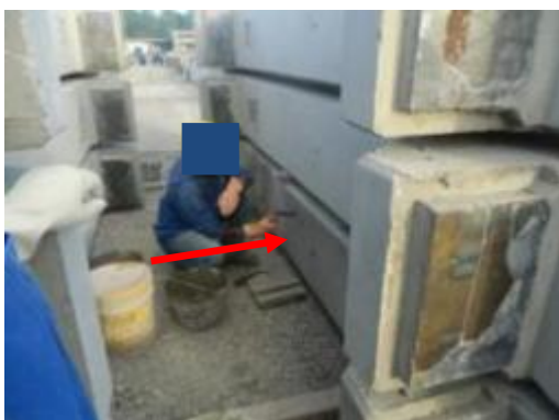
(C) Execução de acabamento das faces do pilar.
