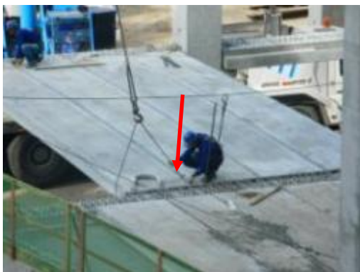
(C) Retirada dos cabos da içagem da laje
