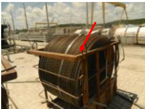
(A) Cordoalhas para a proteção da laje.
