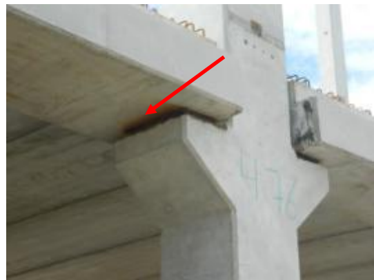
(B) Conclusão de solda para fixação da viga nos pilares.
