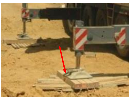
(C) Plataforma de toros de madeira para o patolamento de guindastes.
