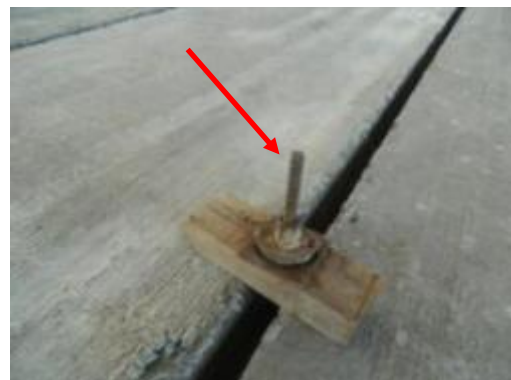
(B) Conjunto instalado entre duas lajes desniveladas.
