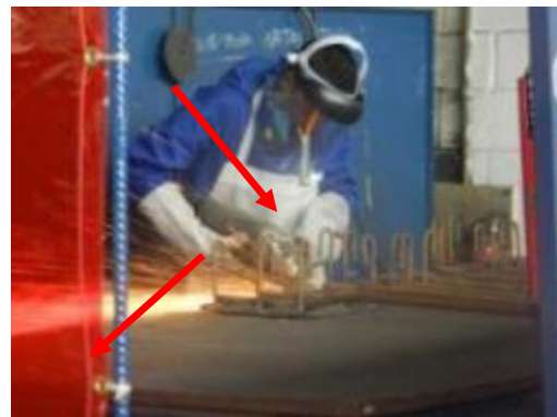
(B) Emprego de corte e solda na confecção de armações, com barreira de proteção
