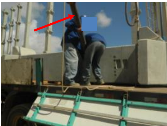
(A) Instalação do pino no pilar
