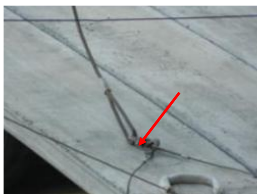
(D) Cabo de aço para o içamento.
