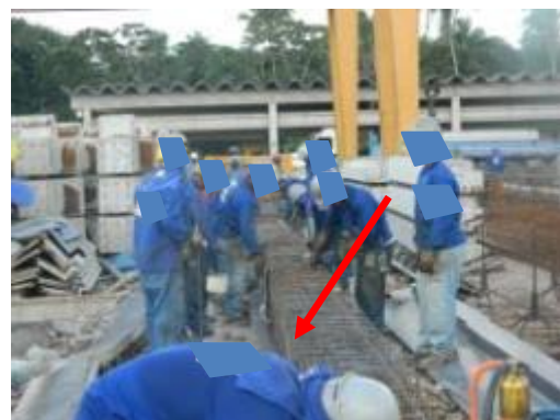
(D) Montagem das armações na Pista.
