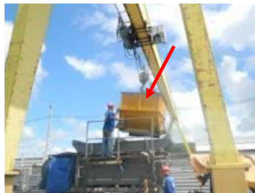
(B) Abastecimento e concretagem com a moldadora / extrusora móvel
