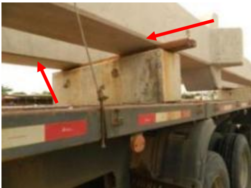
(C) Chegada dos pilares na obra
