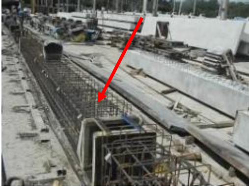
(A) Montagem das armações na pista
