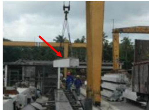
(B) Içamento para o transporte
