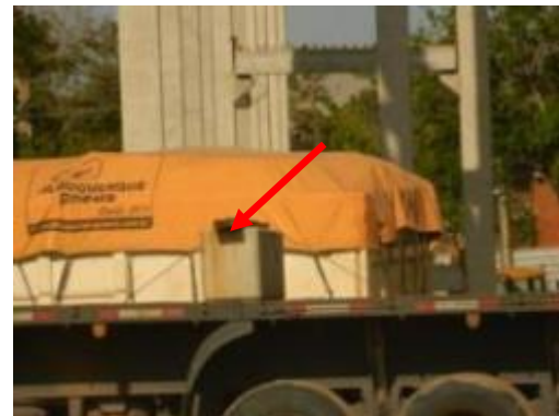
(F) Dormente utilizado para o apoio do pilar durante o transporte
