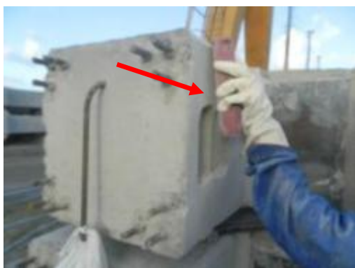
(D) Execução de acabamento das faces do pilar
