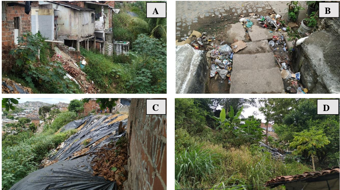
Figura 50 - a) construções irregulares; b) disposição de resíduos sólidos; c) entupimento das valas de drenagem; e d) vegetação inadequada.
