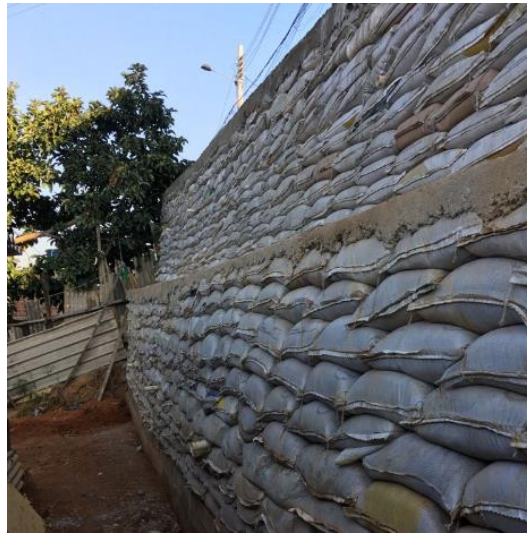
Figura 5 - Muro de contenção de solo-cimento ensacado
