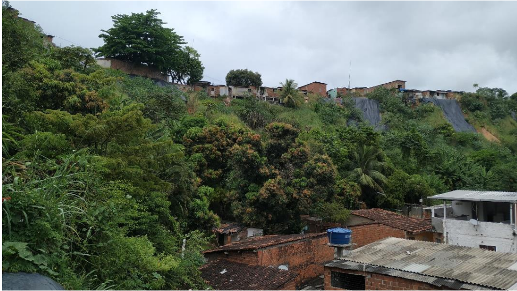
Figura 1 - Ocupação irregular de encosta: Rua Alto do Olho d'água-Macaxeira-Recife-PE
