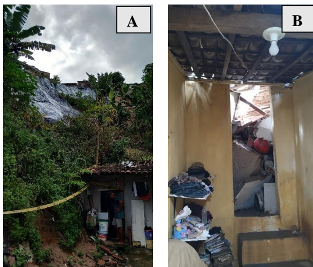
Figura 62 - Deslizamento (jun.2022): área deslizada (A); e imóvel afetado (B)
