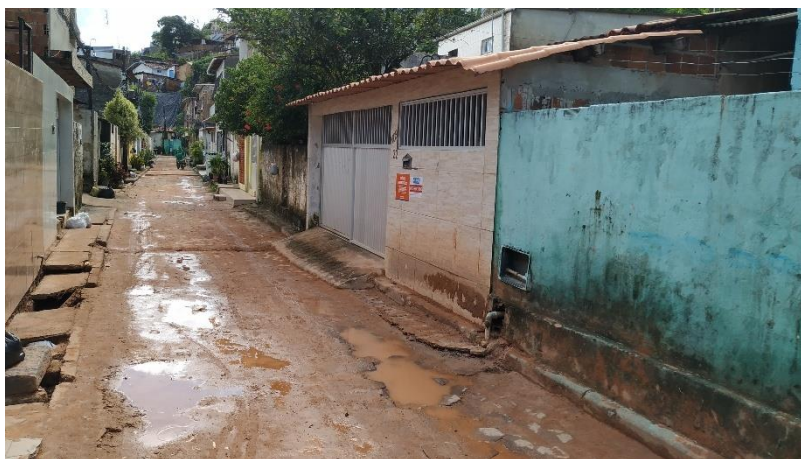
Figura 61 - Casas interditadas pela Defesa Civil (jun.2022)
