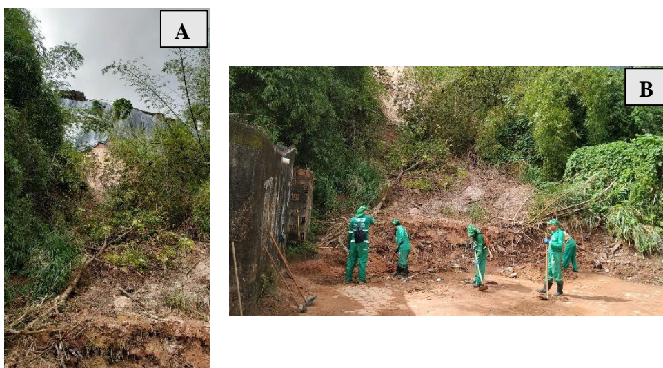
Figura 63 - Deslizamento (jun.2022): área deslizada (A); e rua interditada (B)
