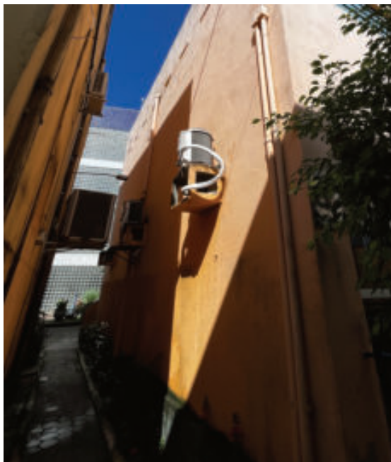
Figura 144 – Fachada lateral esquerda do bloco G
