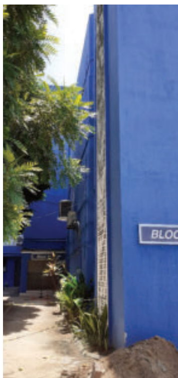
Figura 222 – Fachada lateral esquerda do bloco J
