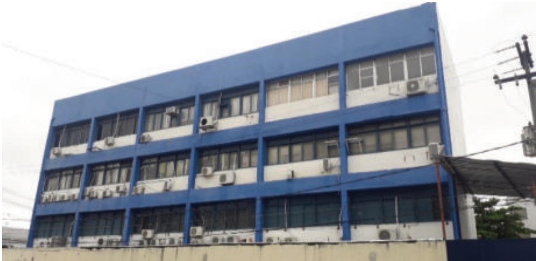
Figura 79 – Fachada posterior do bloco C
