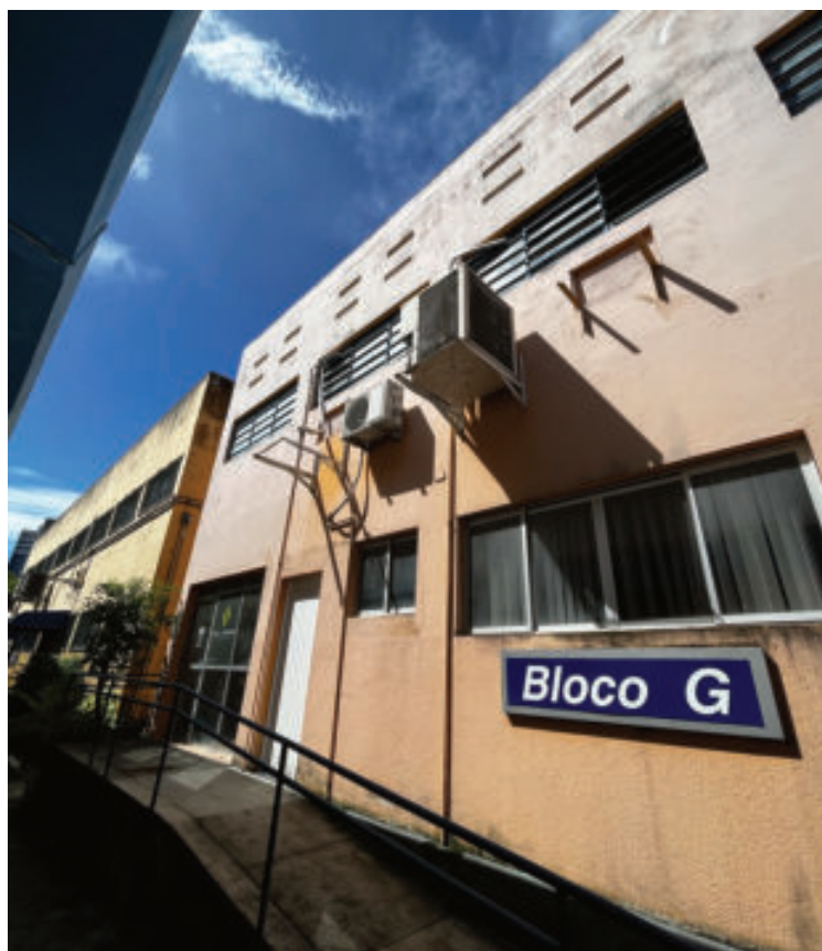
Figura 127 – Fachada frontal do bloco G
