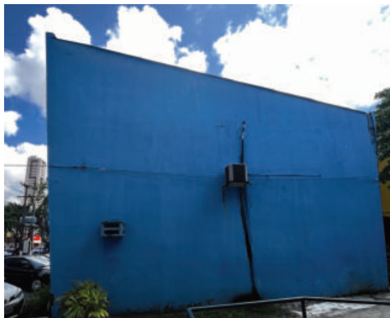
Figura 48 – Fachada lateral direita do bloco B
