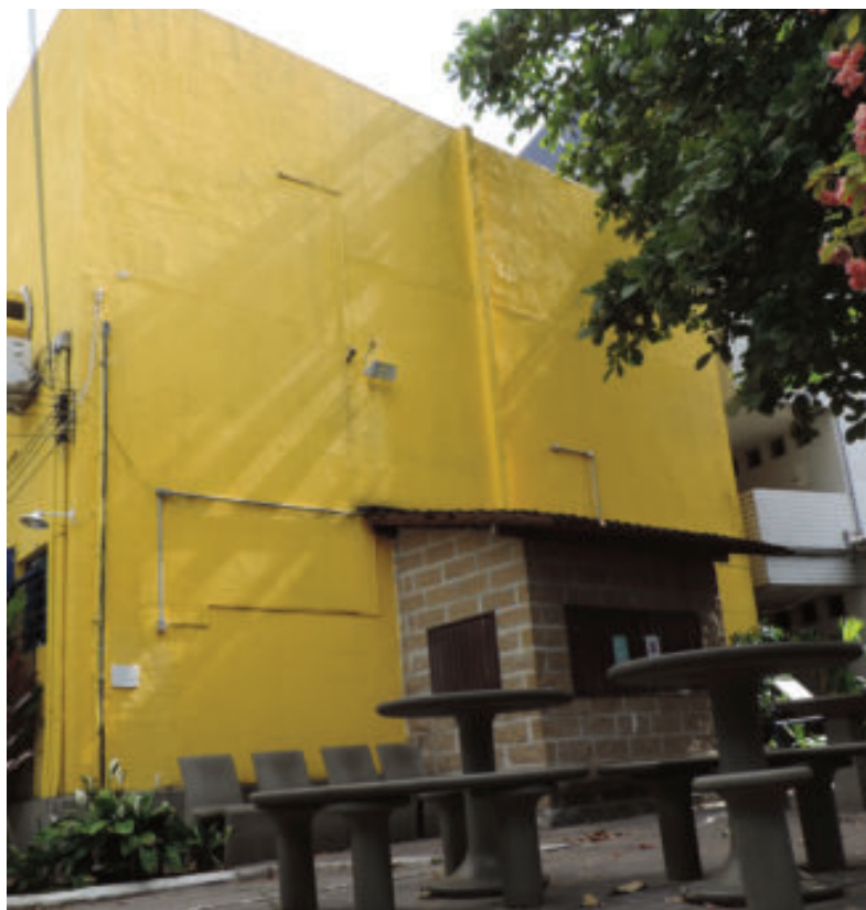
Figura 113 – Fachada lateral direita do bloco F
