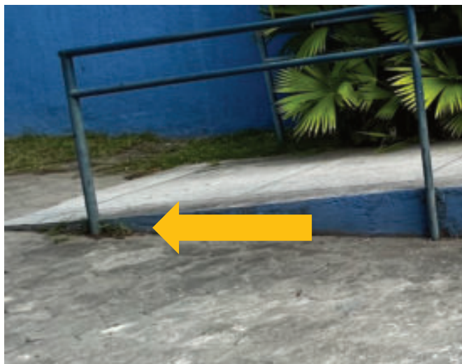
Figura 217 – Vegetação na fachada frontal do bloco J
