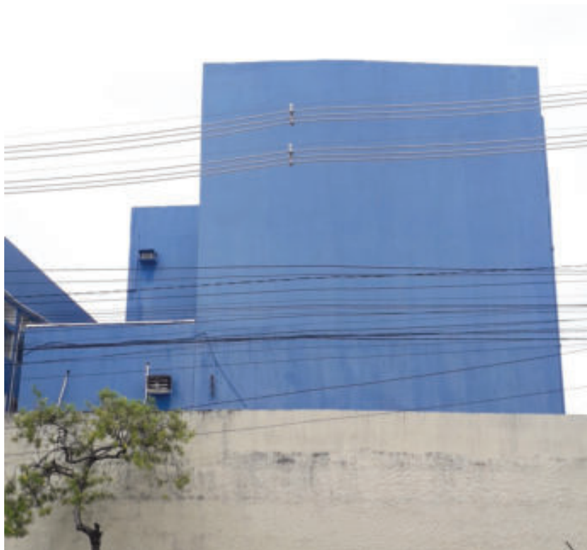
Figura 74 – Fachada lateral direita do bloco C
