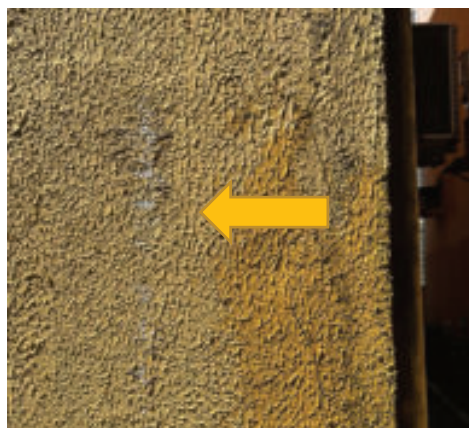
Figura 164 – Pintura destacada
