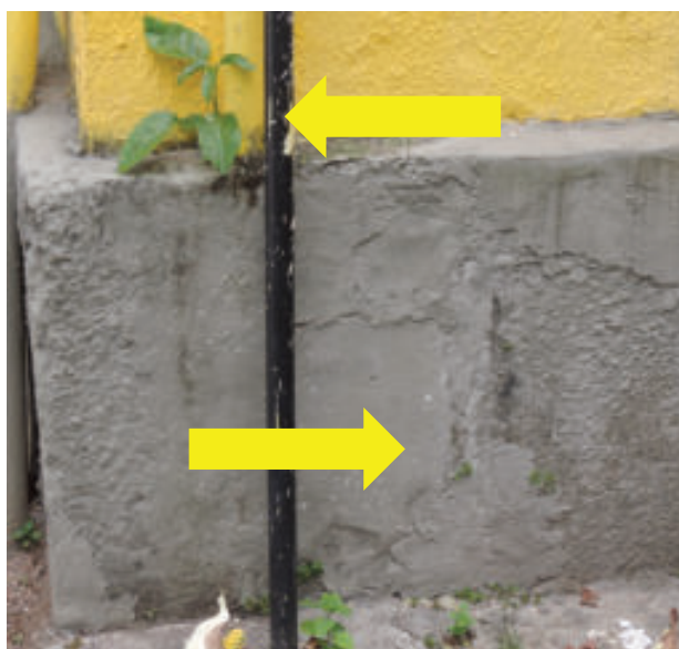
Figura 115 – Vegetação da fachada lateral direita do bloco F
