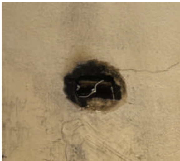
Figura 185 – Abertura na fachada posterior do bloco H
