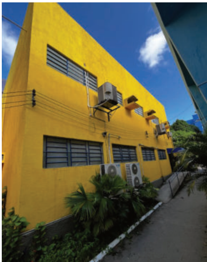
Figura 109 – Fachada frontal do bloco F
