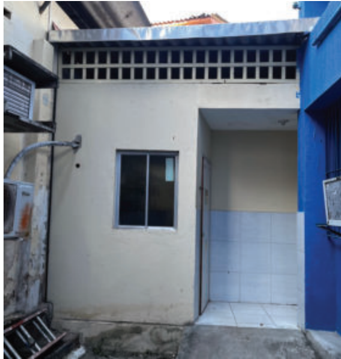
Figura 84 – Entrada do laboratório da fachada frontal do bloco D
