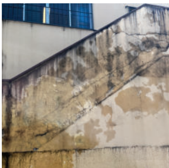
Figura 191 – Fissura diagonal na fachada posterior do bloco H
