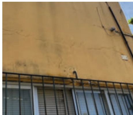
Figura 188 – Fissura horizontal
