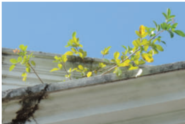
Figura 20 – Vegetação na fachada frontal do bloco A
