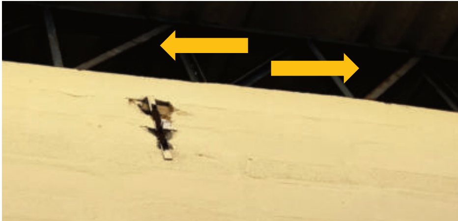
Figura 102 – Corrosão nas peças da cobertura da fachada posterior do bloco D
