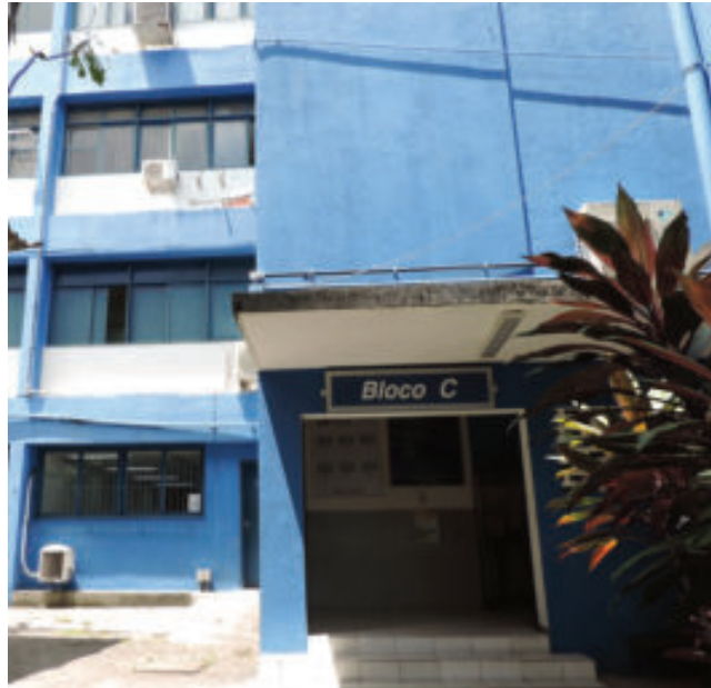
Figura 66 – Fachada frontal do bloco C
