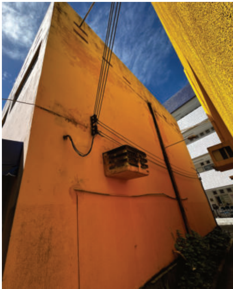
Figura 135 – Fachada lateral direita do bloco G
