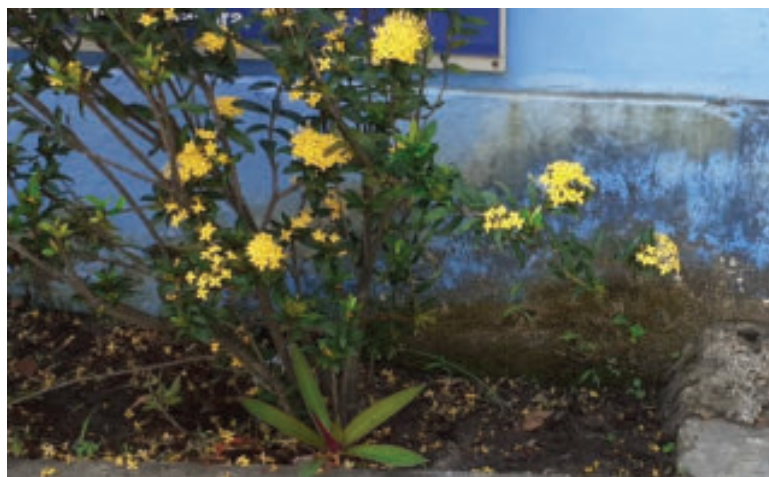
Figura 41 – Mofo e bolor na fachada frontal do bloco B
