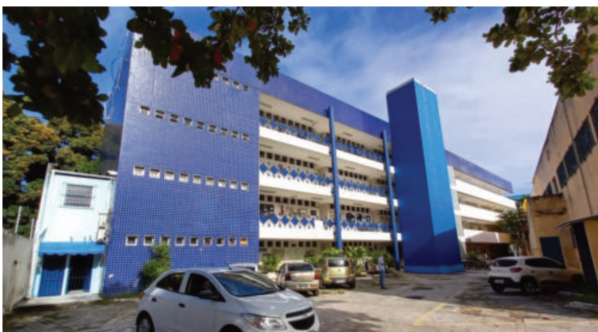
Figura 195 – Fachada frontal dos blocos I e K
