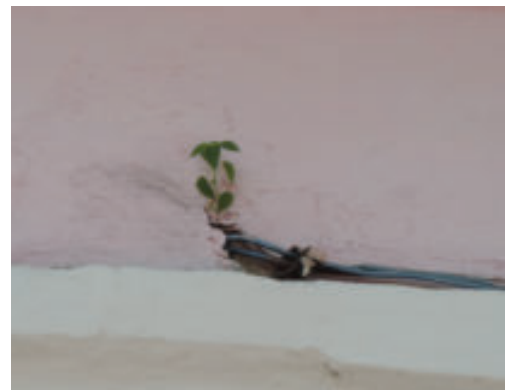
Figura 28 – Vegetação na abertura da fachada
