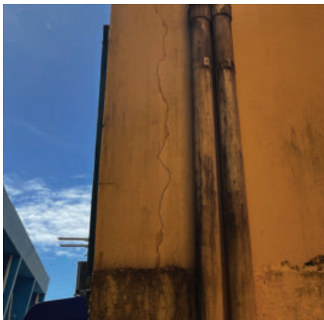
Figura 174 – Fissura vertical no pilar da fachada lateral direita do bloco H
