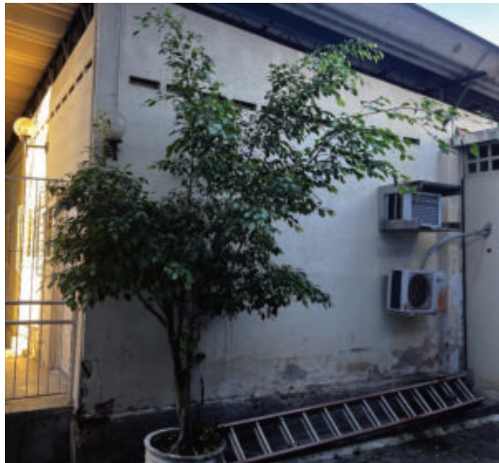
Figura 91 – Fachada lateral direita do bloco D
