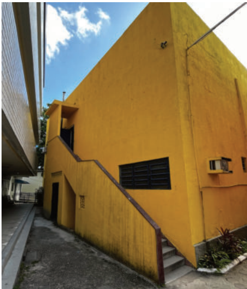
Figura 121 – Fachada posterior do bloco F
