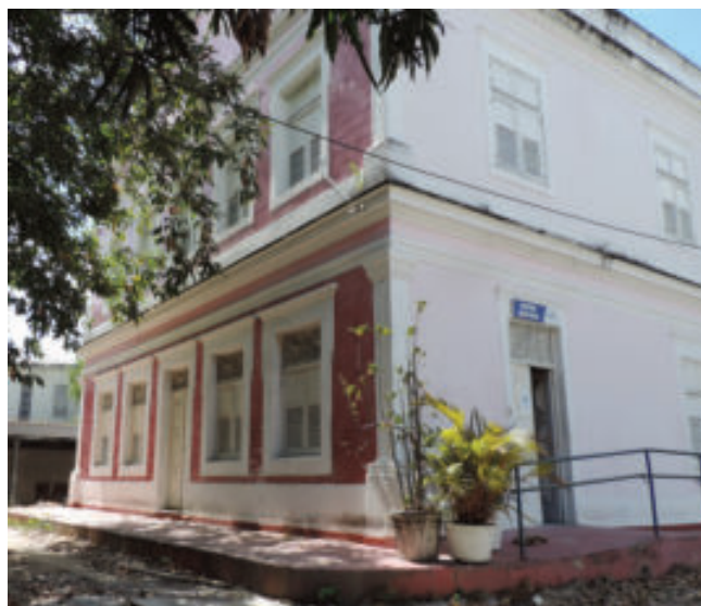
Figura 16 – Fachada frontal do bloco A
