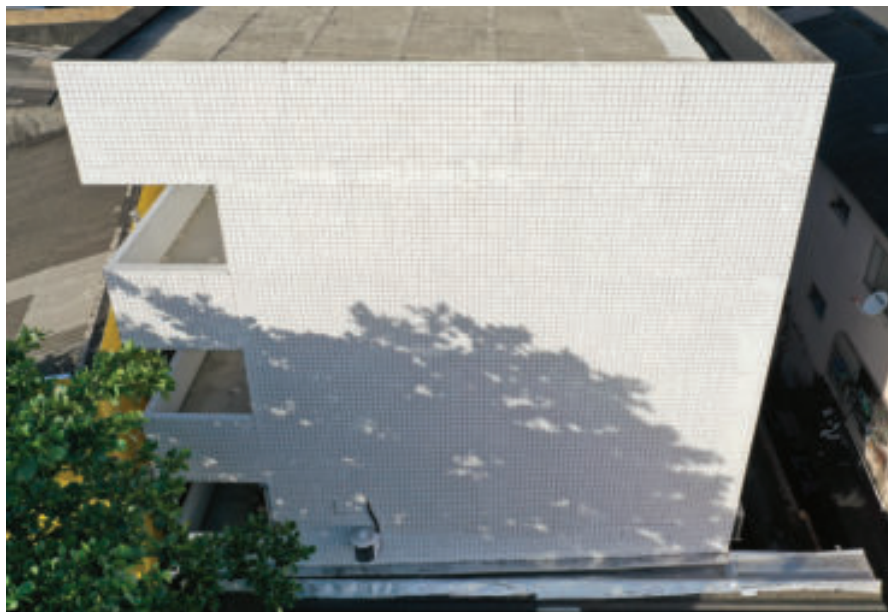
Figura 206 – Fachada lateral direita dos blocos I e K
