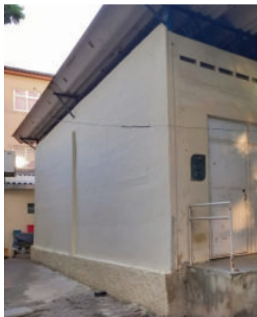
Figura 96 – Fachada lateral esquerda do bloco D
