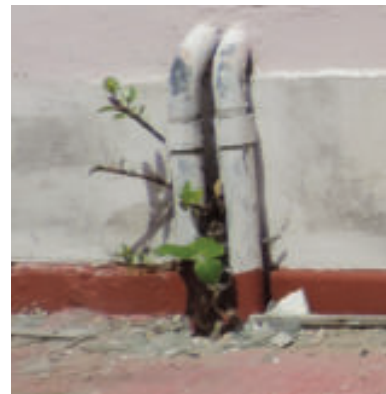
Figura 34 – Vegetação por trás da tubulação
