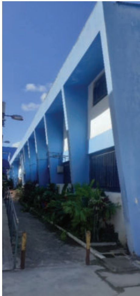
Figura 59 – Fachada posterior do bloco B
