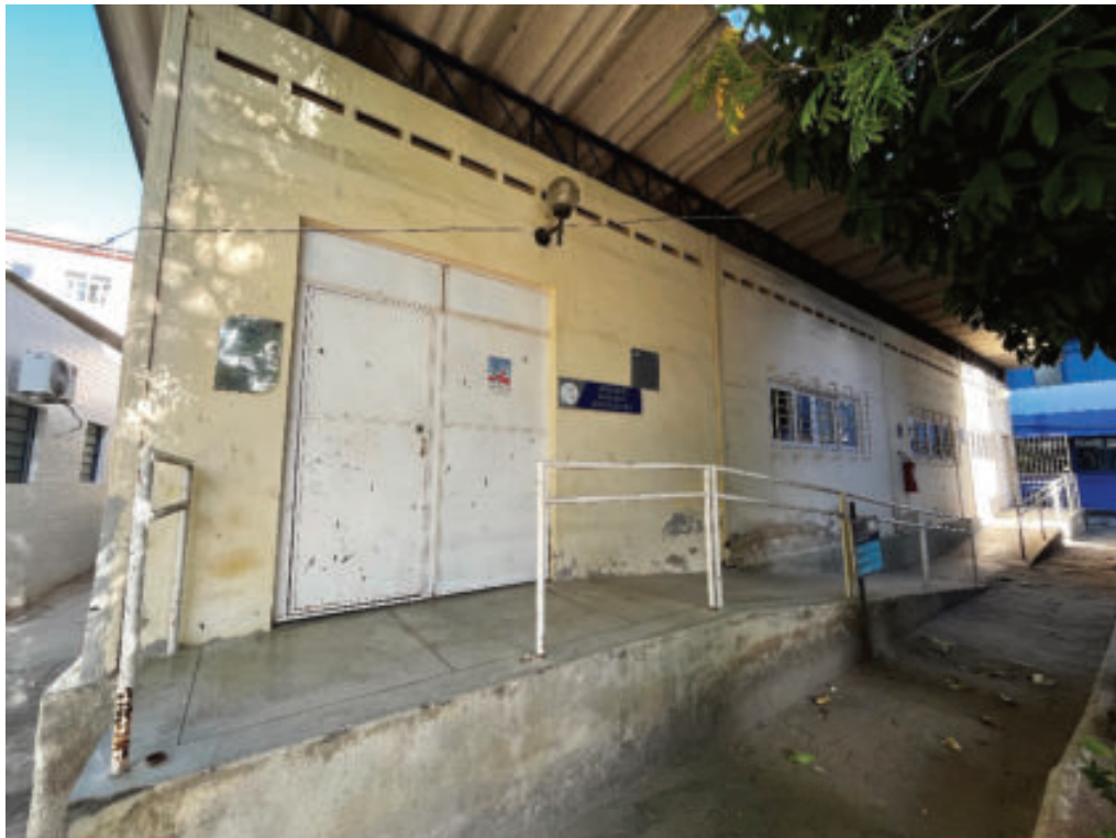
Figura 83 – Fachada frontal do bloco D
