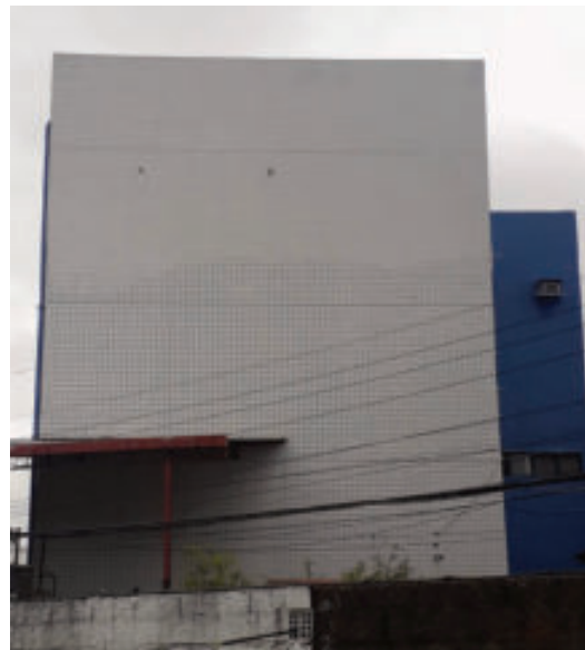
Figura 76 – Fachada lateral esquerda do bloco C
