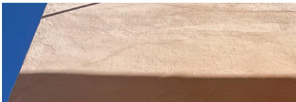
Figura 147 – Fissuras na parte superior da fachada lateral esquerda do bloco G
