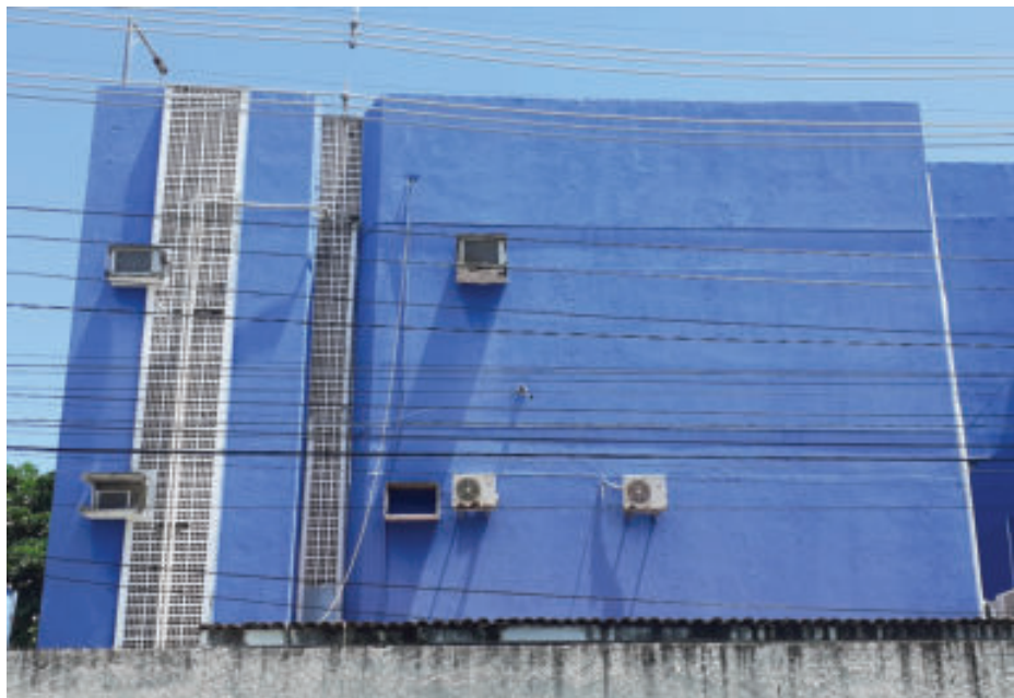
Figura 219 – Fachada lateral direita do bloco J
