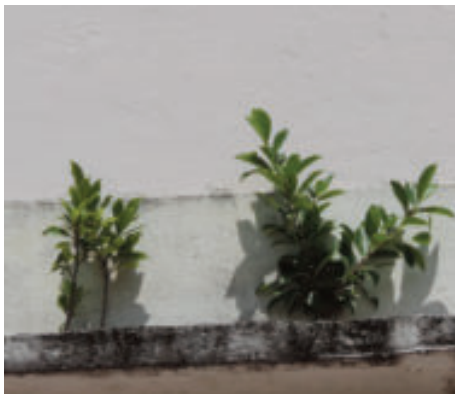
Figura 33 – Vegetação na cornija entre pavimentos
