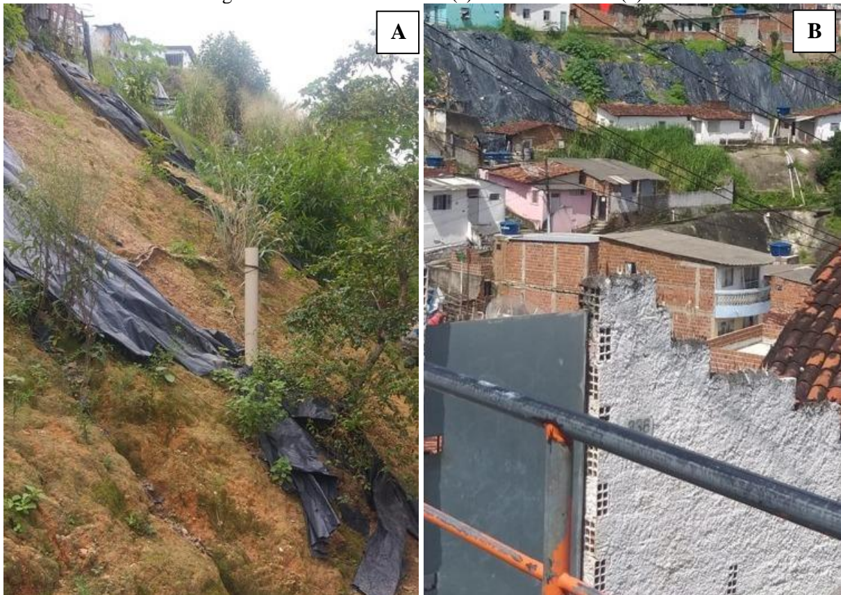
Figura 18 - Talude em estudo (a) e área em estudo (b)
