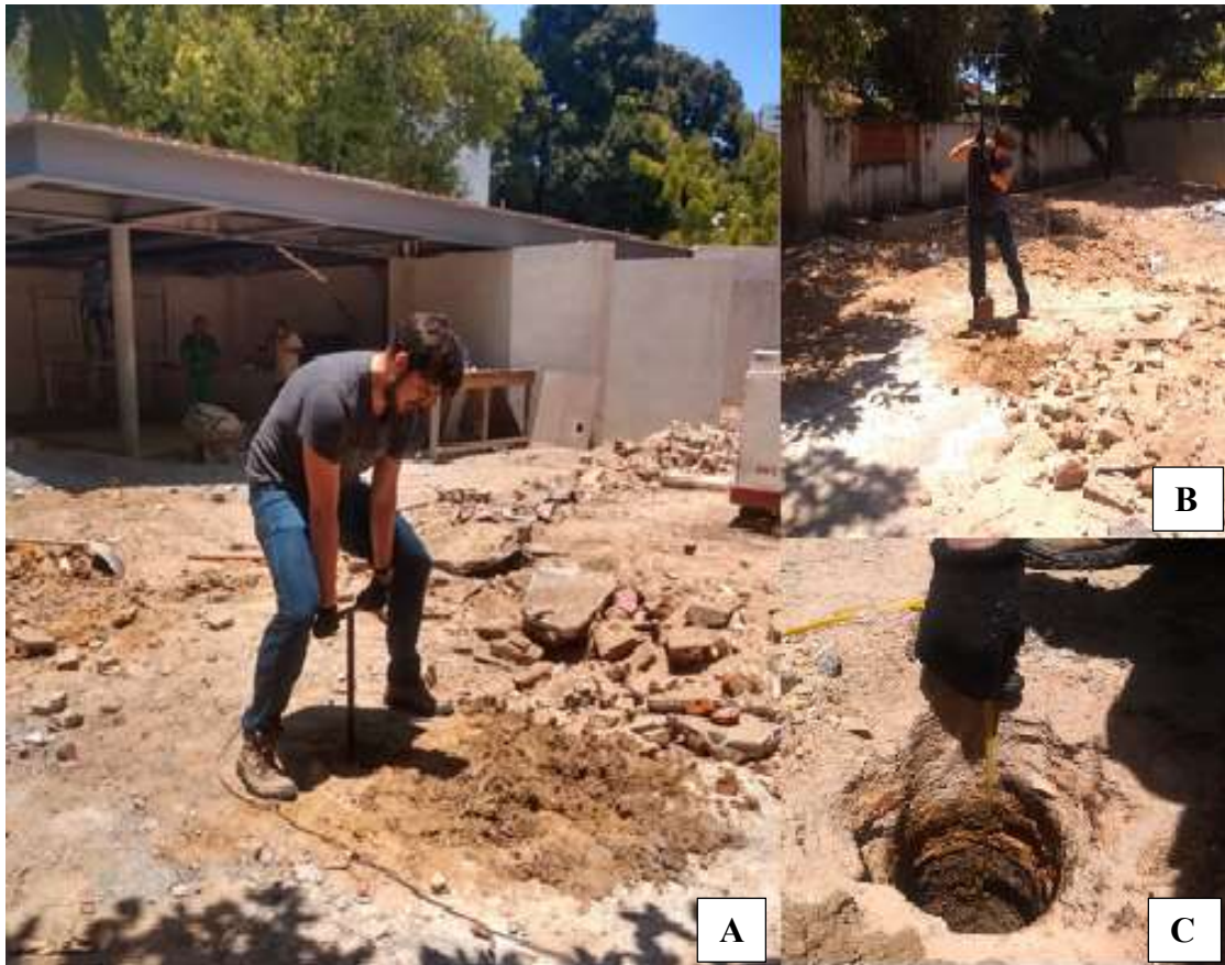
Figura 24 - Sondagem investigativa do nível do lençol freático local. Perfuração com o trado manual (a), retirada do trado com material (b), aferição do nível d'água do lençol freático (c)
