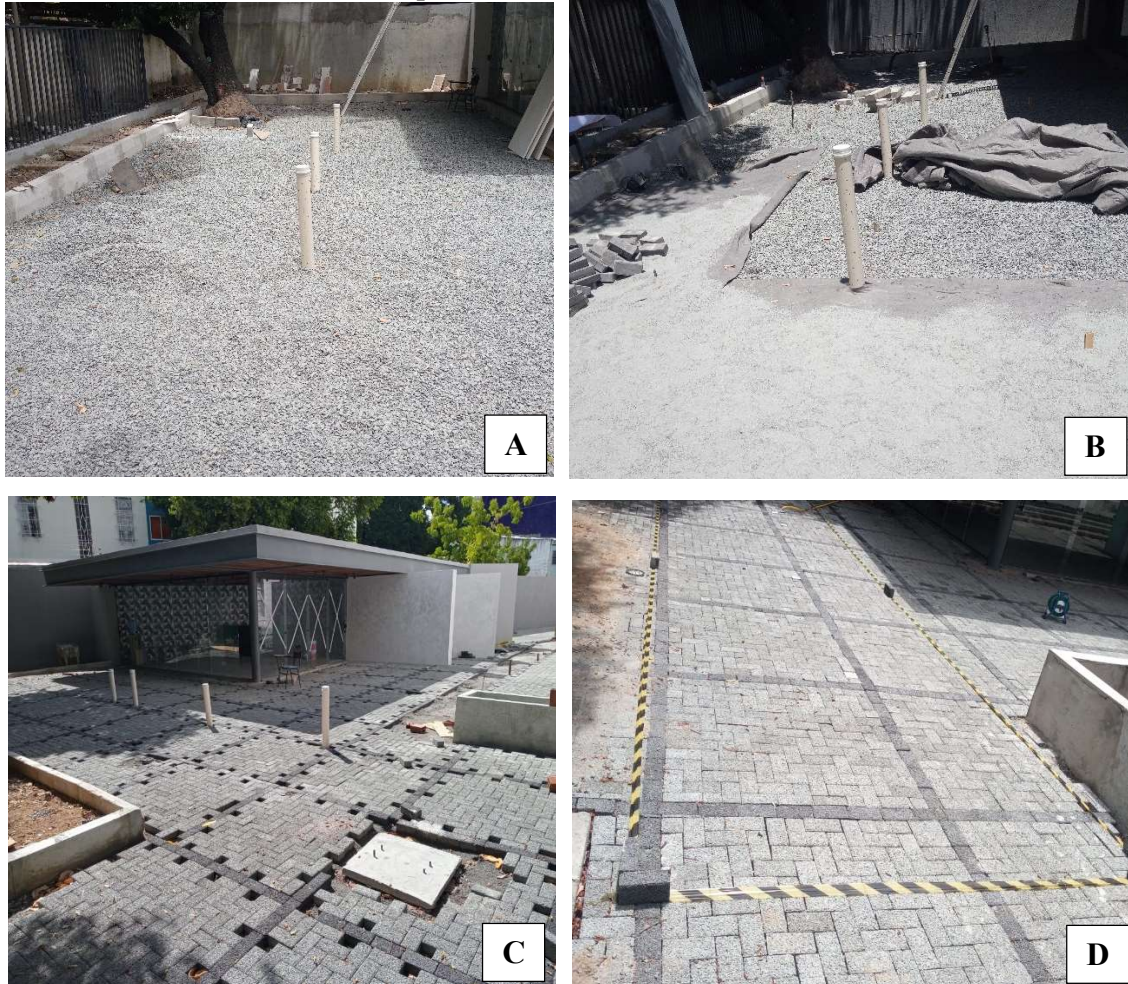
Figura 69 – Execução do pavimento permeável na POLI-UPE. Distribuição da brita na camada de base (a), colocação da manta e da camada de assentamento (b), execução do revestimento (c), pavimento finalizado (d)
