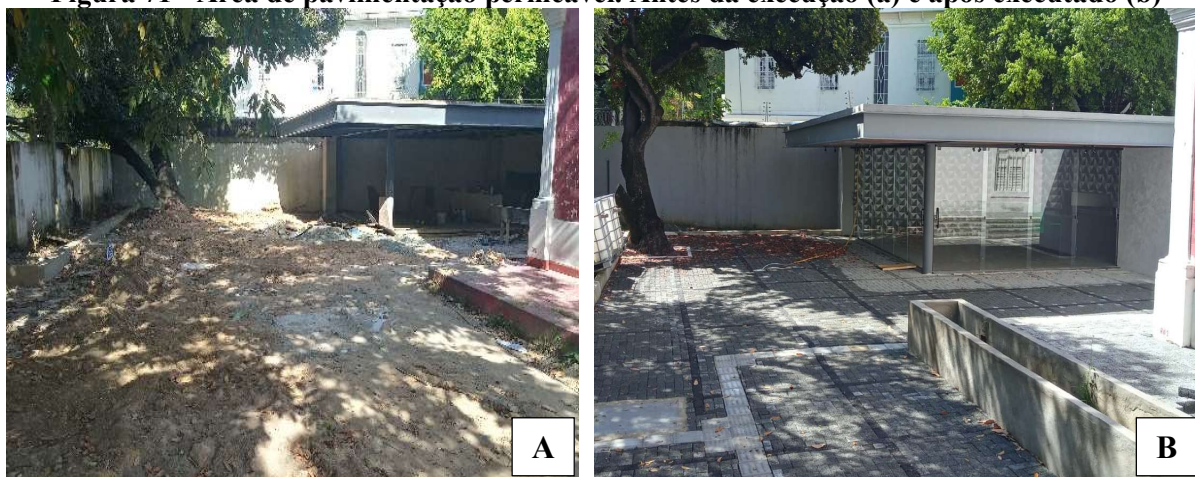
Figura 71 - Área de pavimentação permeável. Antes da execução (a) e após executado (b)
