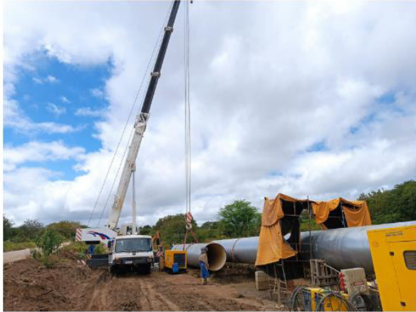
Foto 3 - Implantação da adutora
