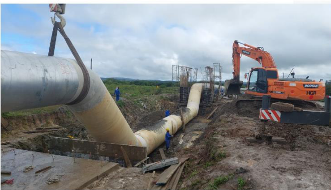
Foto 5 - Implantação travessia enterrada
