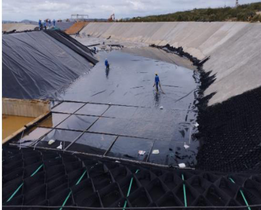
Foto 7 - Execução do reservatório de água bruta
