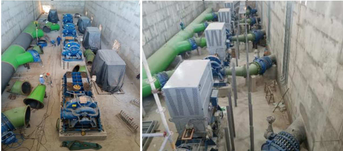
Foto 9 - Montagem hidro-eleto-mecânica Foto 10 -Visão geral da Estação Elevatória (EEAB)
