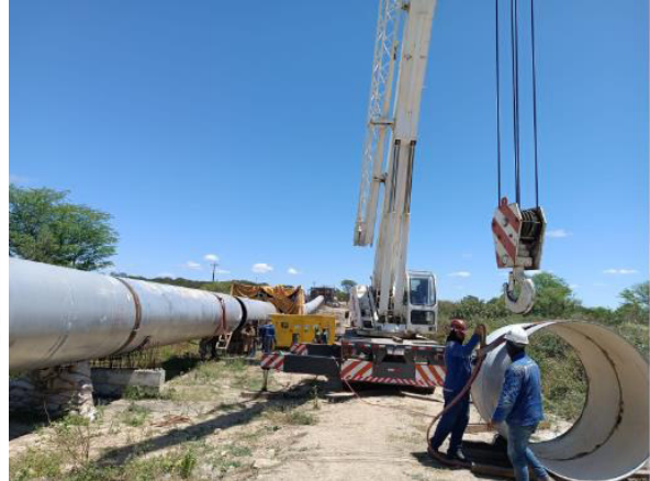
Foto 4 - Trecho aéreo da adutora (recalque)
