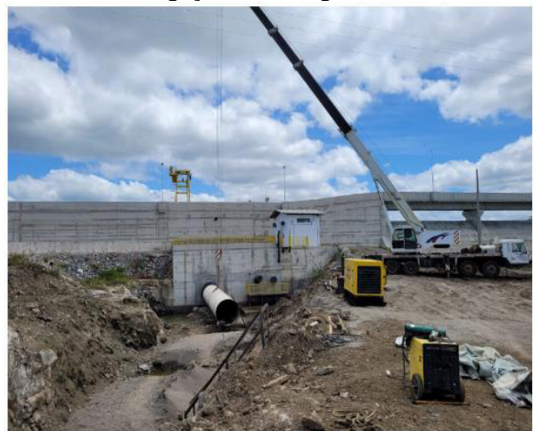
Foto 2 - Interligação na barragem
