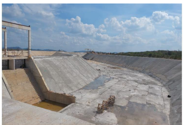
Foto 8 - Conclusão do reservatório ( V=70.000\text{ m}^3 )
