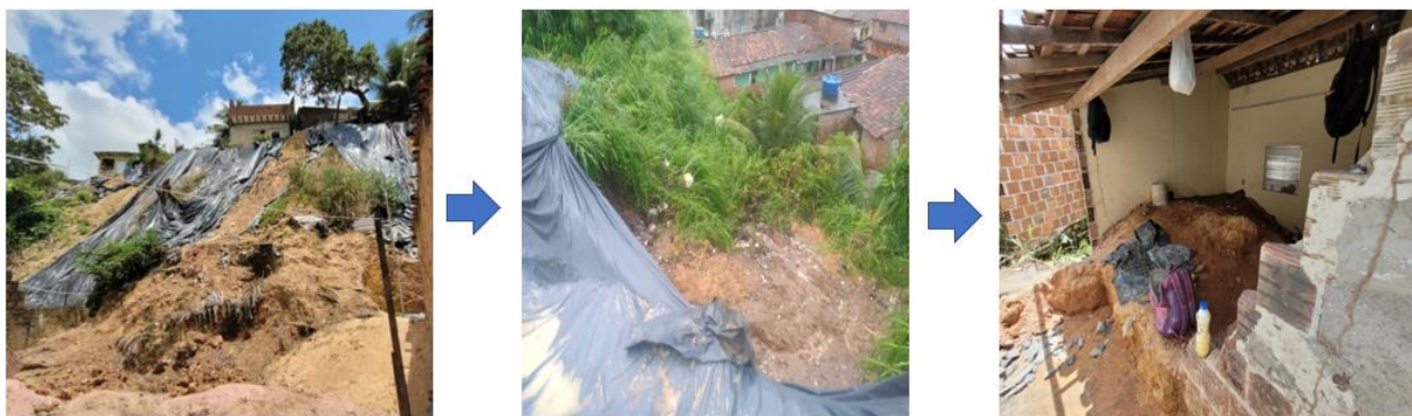
Figura 22: Deslizamento de Encosta no Córrego do Leôncio no inverno de 2022 - Nova Descoberta/PE.
