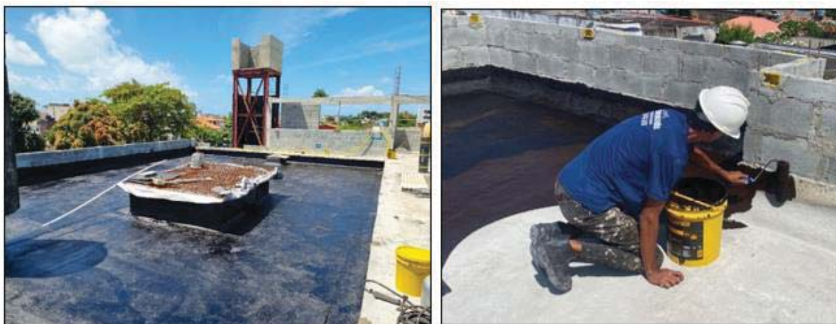
Figura 41 – Execução da aplicação da camada de prime.
