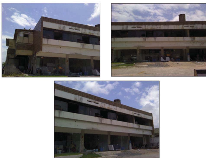
Figura 65 – Registros da fachada Norte.
