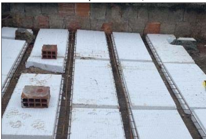
Figura 35 – 1ª Camada com placas de EPS (1.000 x 330 x 65 mm).
