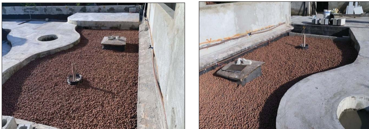
Figura 46 – Aplicação de argila expandida
