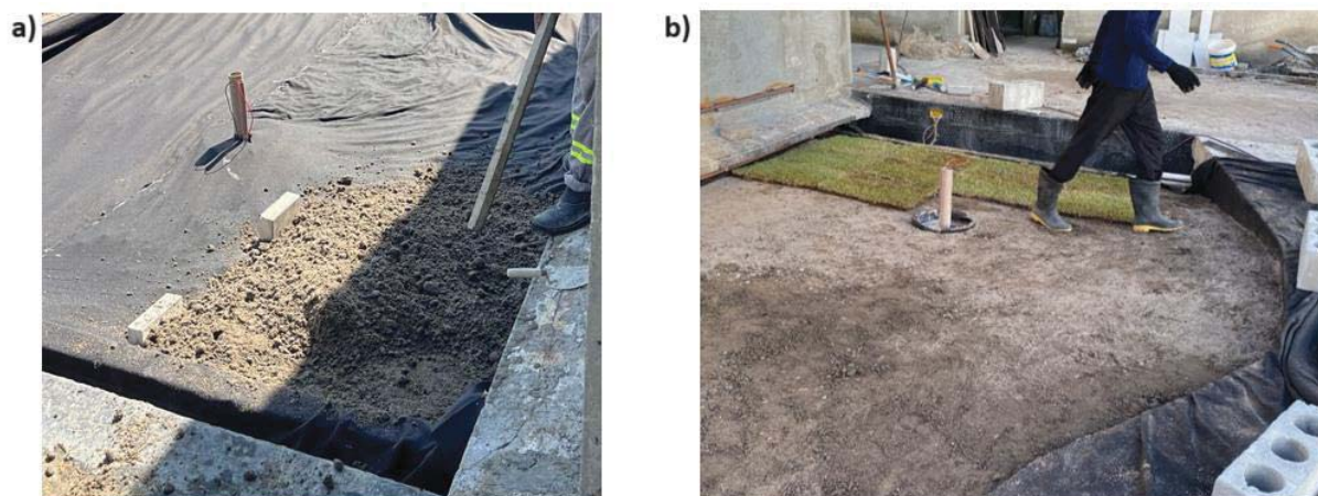
Figura 49 – Registros da aplicação da camada do substrato.
