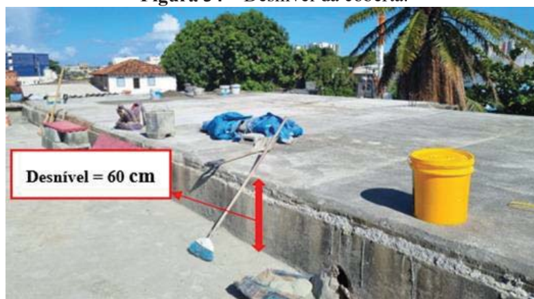
Figura 34 – Desnível da cobertura.
