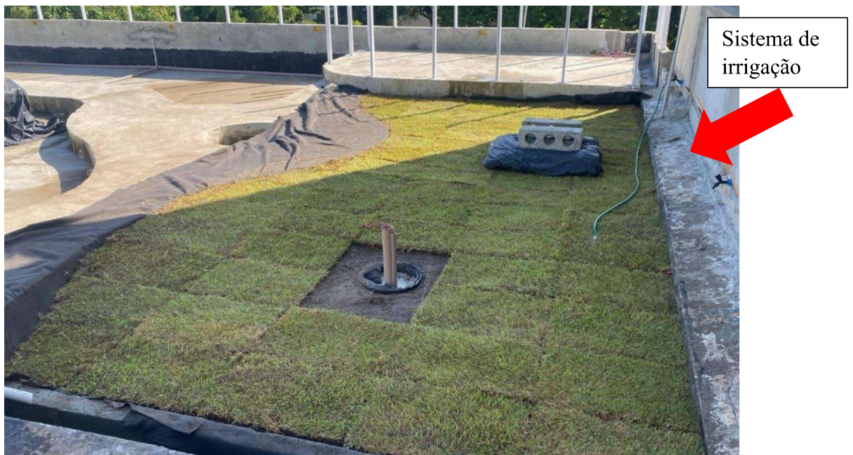
Figura 51 – Sistema de irrigação da camada vegetal.
