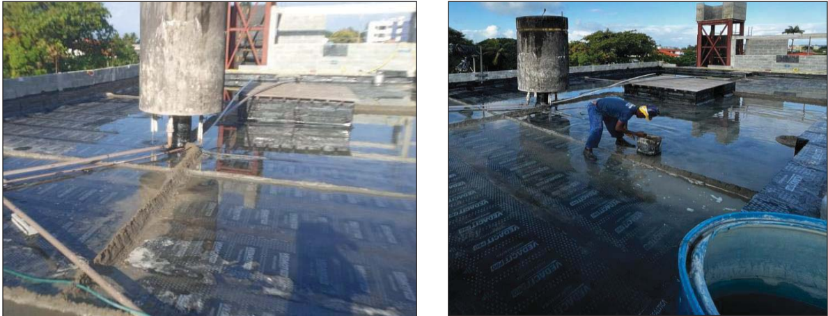
Figura 43 – Teste de estanqueidade do sistema de impermeabilização.
