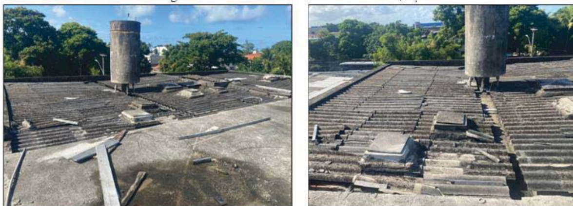
Figura 23 – Coberta com telha de fibrocimento
