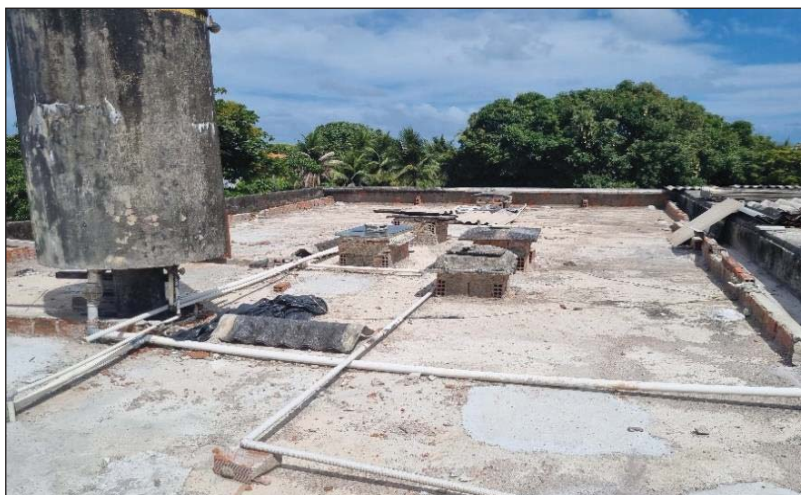
Figura 24 – Coberta após remoção das telhas de fibrocimento.
