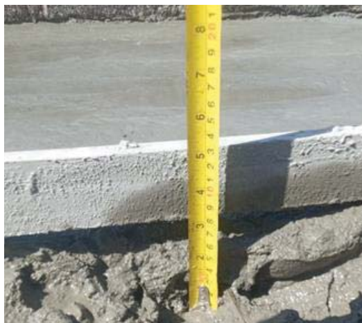
Figura 10 – Espessura da camada de regularização.
