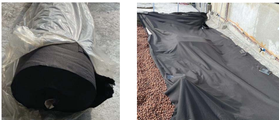
Figura 11 – a) Rolo do tecido permeável com 2,30 x 100m b) Aplicação do tecido permeável Bidim sobre a camada drenante.
