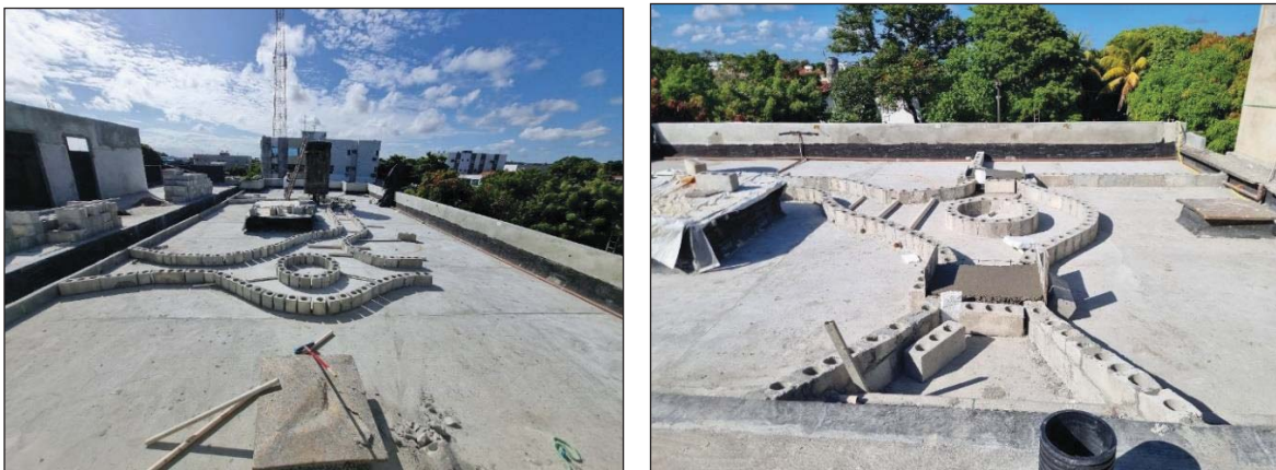
Figura 44 – Proteção mecânica aplicado sobre o sistema de impermeabilização, com instalação de bloco de concreto celular no layout de passeio da cobertura.
