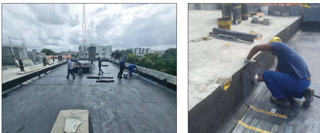
Figura 42 – Aplicação de manta asfáltica Anti Raiz
