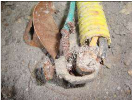
Figura 36 - Eletrodo de aterramento sob medição
