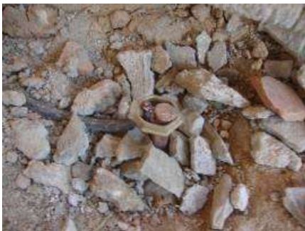
Figura 37- eletrodo de aterramento sob medição
