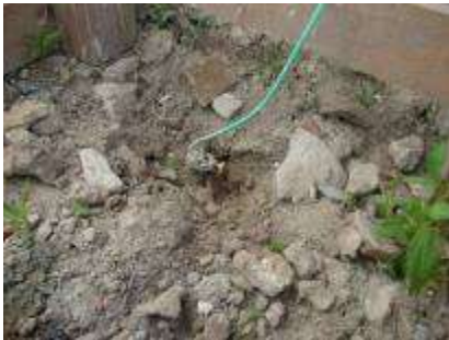
Figura 38 - eletrodo de aterramento sob medição
