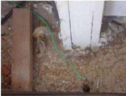
Figura 34 - Eletrodo de aterramento sob medição
