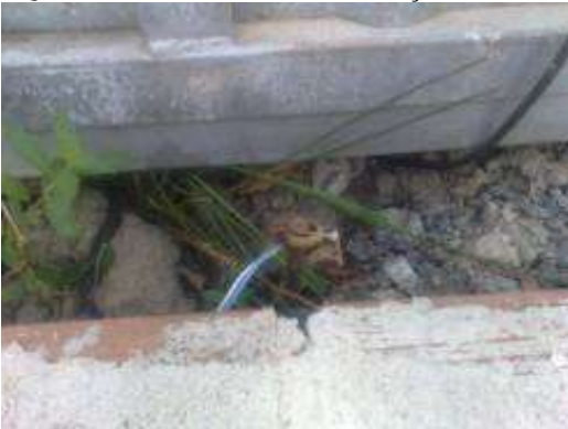
Figura -. 35 eletrodo de aterramento sob medição
