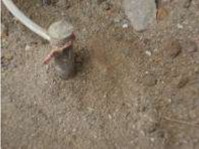
Figura32- eletrodo de aterramento
