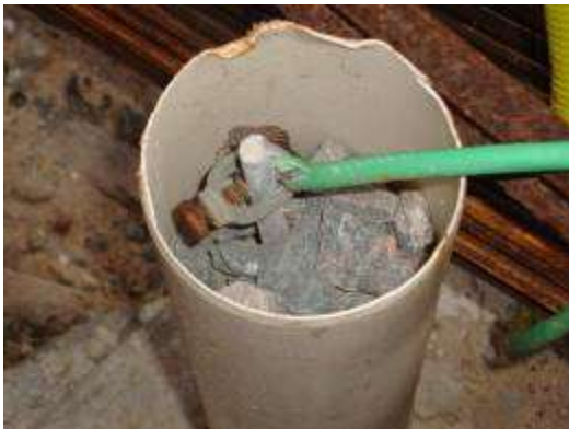
Figura 33- eletrodo de aterramento sob medição
