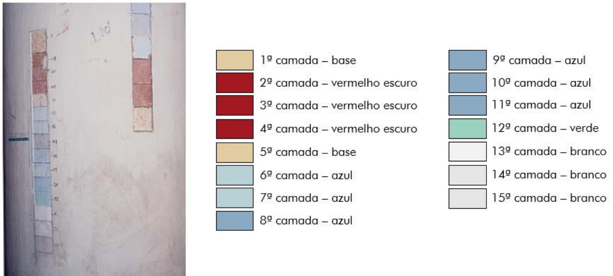
Figura 27 - Janela de prospecção em pilar e suas camadas
