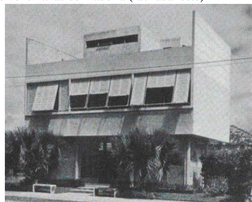
Figura 13 - Parede de cobogós (fachada oeste) e venezianas de madeira (fachada leste)
