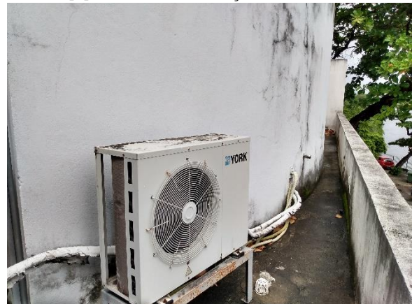
[d] Fachada oeste
