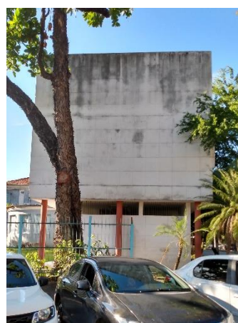
[d] Fachada sul
