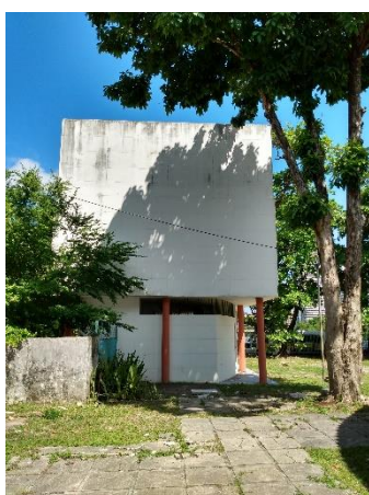
[c] Fachada norte
