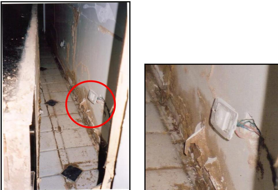
Figura 5: Presença de cupim em estrutura de móvel encostado na alvenaria elétrica. Foto do autor.
