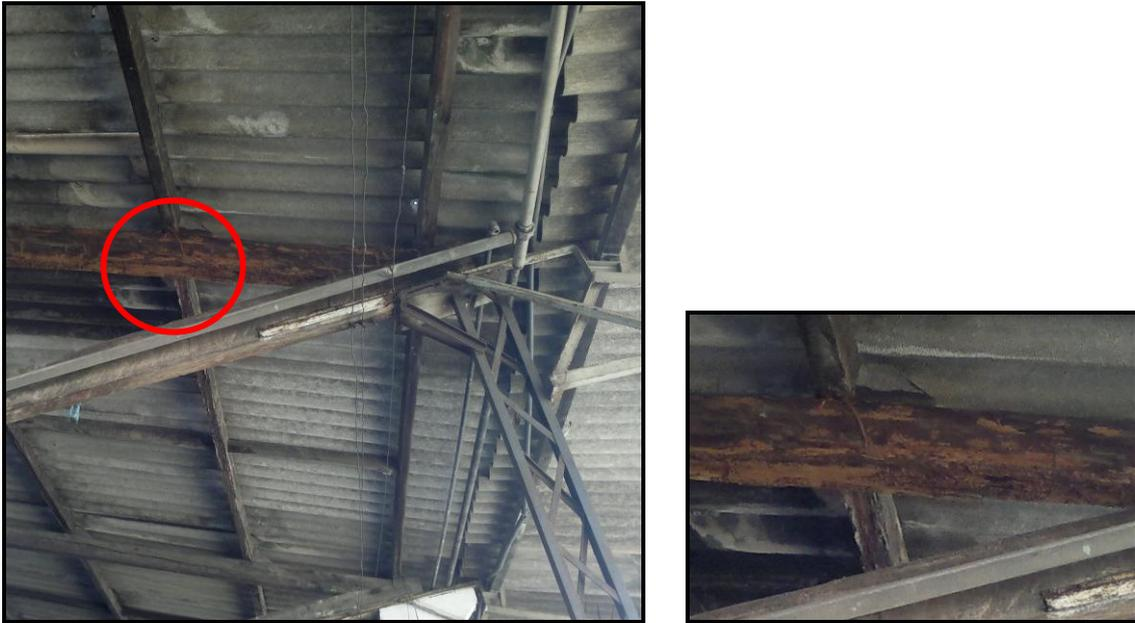
Figura 4: Presença de cupim em estrutura de telhado. Foto do autor.
