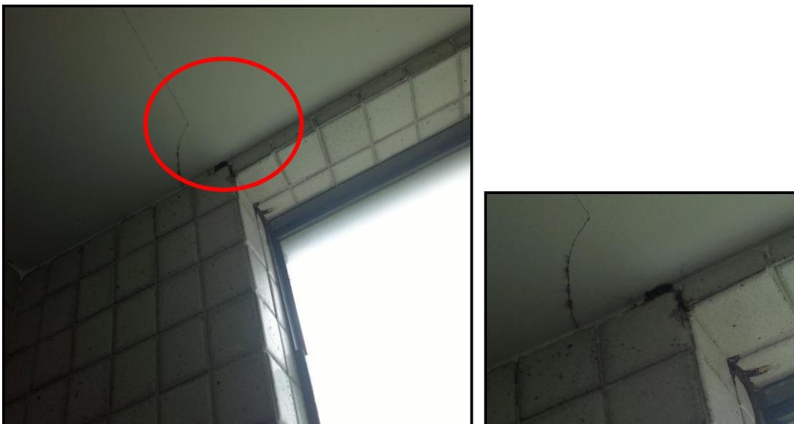
Figura 8: Ocorrência de cupim no interior do forro (gesso). Foto do autor.
