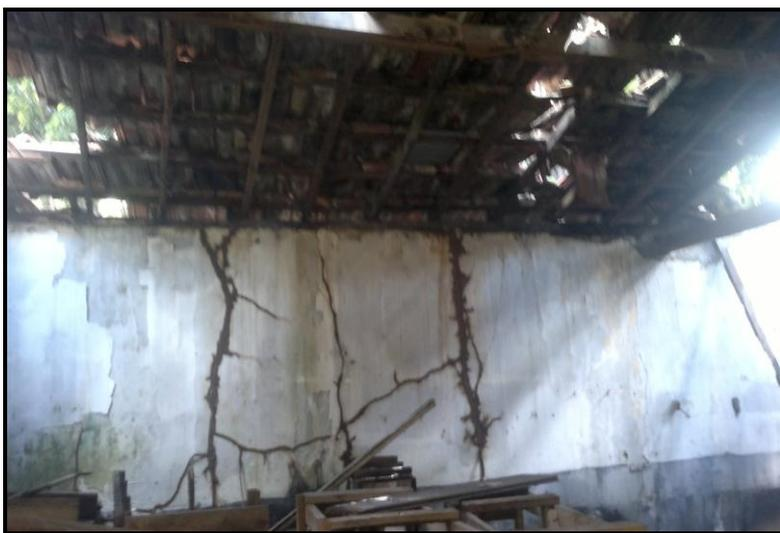
FIGURA 7: Estrutura de cobertura e alvenarias infestadas por cupins. Foto do autor.
