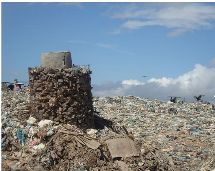
Foto 31 – Drenagem vertical dos gases.
