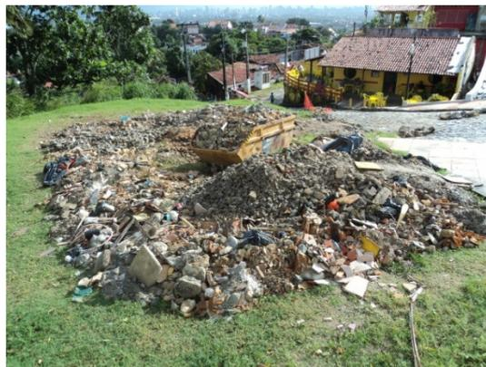
Foto 2 – Deposição de RCC em terreno baldio
