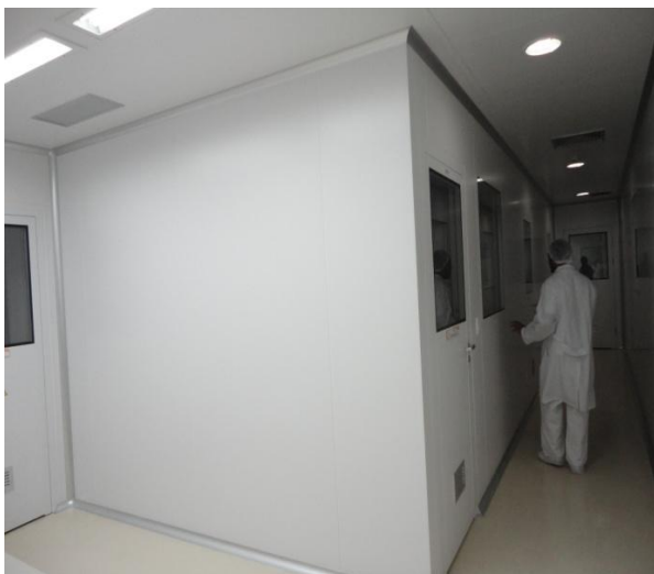
Figura 8.3 – Divisórias Drywall (Sala limpa)
