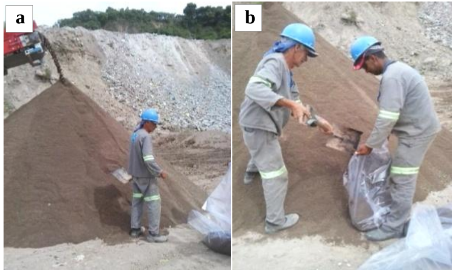
Figura 21 – Pilha de britagem (a) e agregado reciclado de RCD sendo coletado (b).
