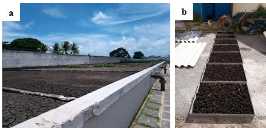
Figura 7 – Leitos de secagem onde o lodo foi coletado (a) e lodo exposto sobre bandejas metálicas para secagem ao sol (b)
