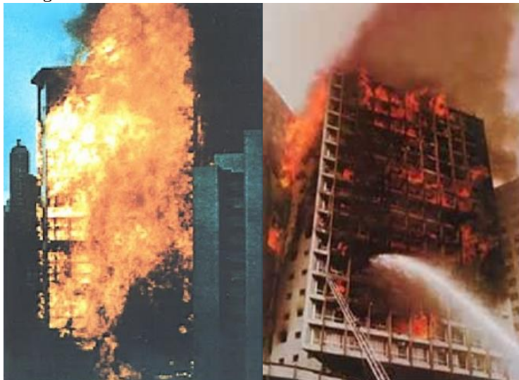
Figura 3: Edifícios Andraus e Joelma no momento do incêndio.
