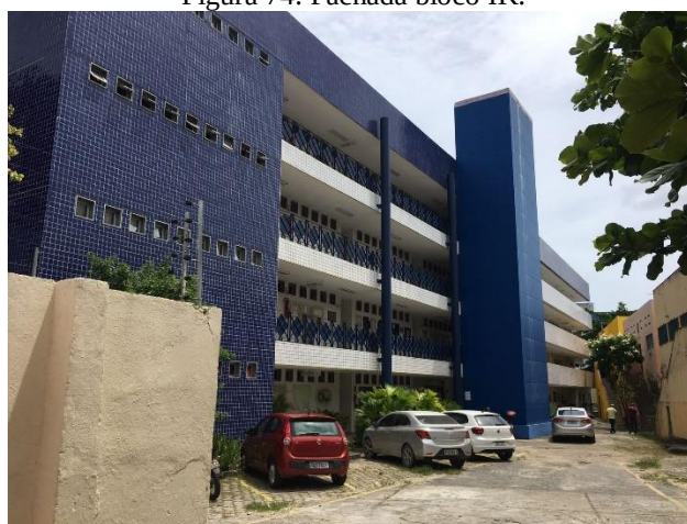
Figura 74: Fachada bloco IK.
