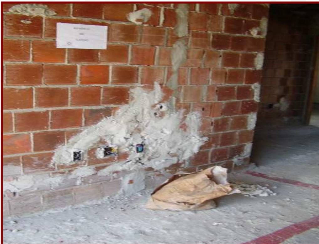
Figura 2.4 - Marcação no piso para acondicionamento inicial do resíduo Classe A
