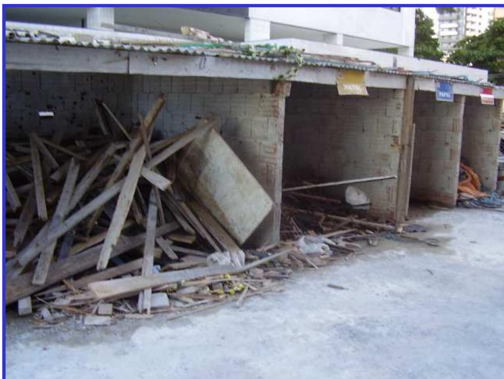
Figura 2.7 - Dispositivos de acondicionamento final tipo baias
