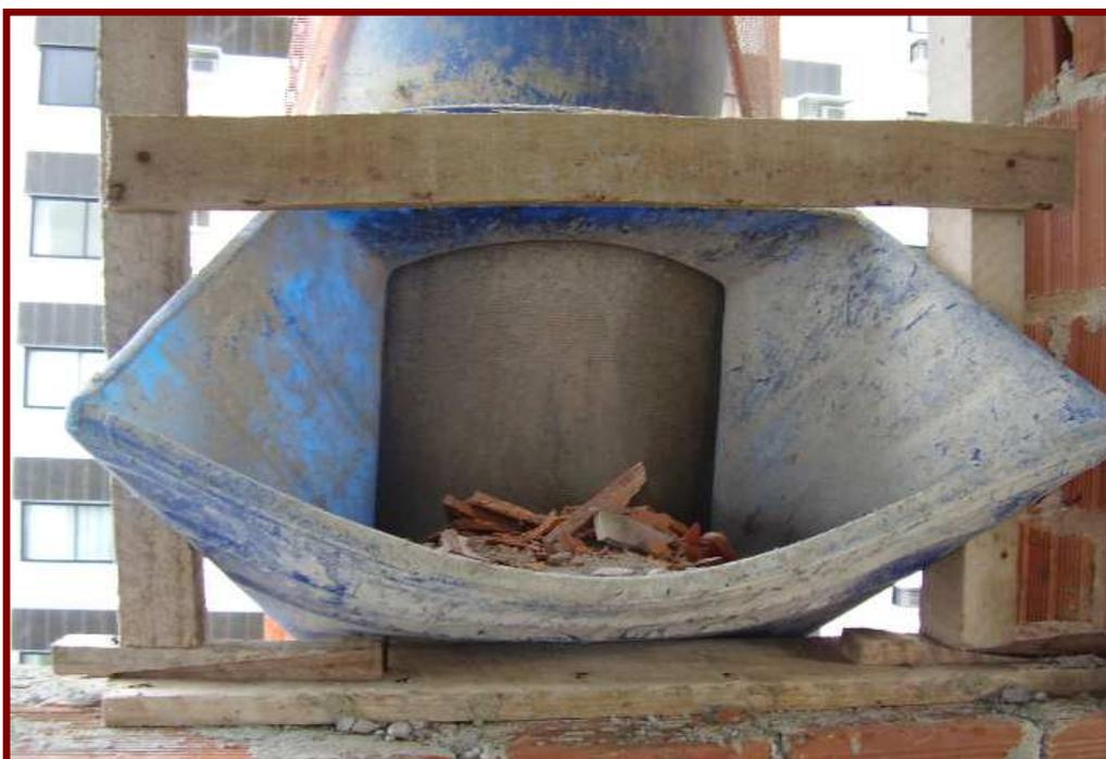
Figura 2.5 - Dispositivo de coleta inicial com tubo coletor de resíduo Classe A
