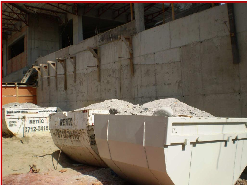
Figura 4.37 - Sobra de argamassa de fachada de uma obra de três torres residenciais na Região Metropolitana de São Paulo armazenada para reúso no piso da área externa
