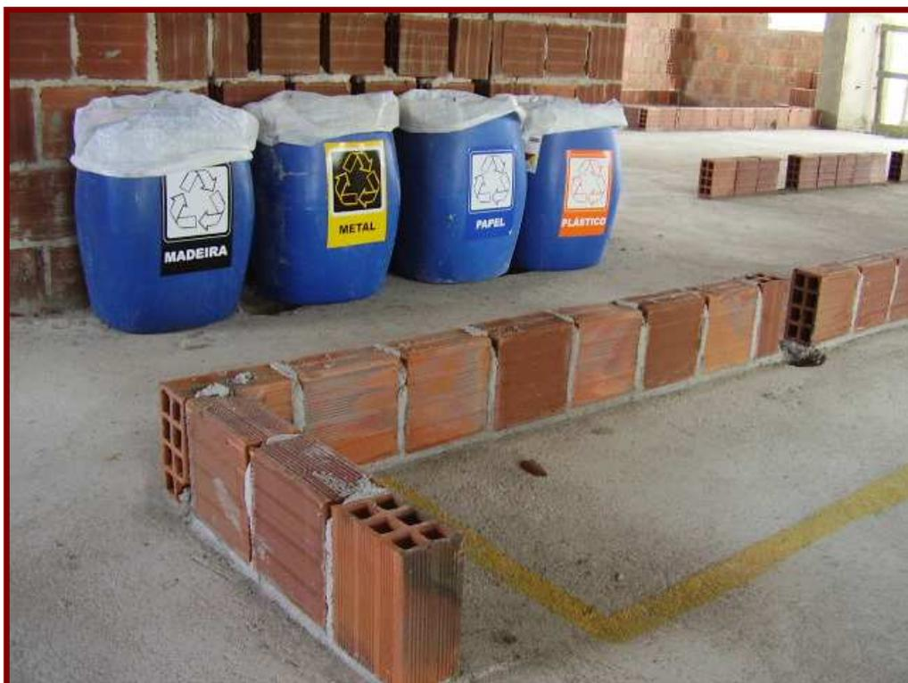
Figura 2.3 - Disposição dos dispositivos de acondicionamento inicial
