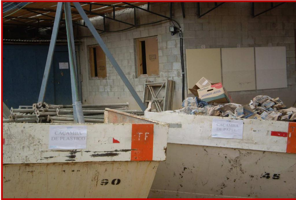
Figura 4.41 - Uso de caçambas para acondicionamento final para plástico e papel
