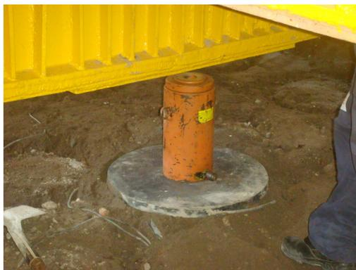
**Figura 3.65** – Macaco hidráulico posicionado abaixo da viga N° 02.
