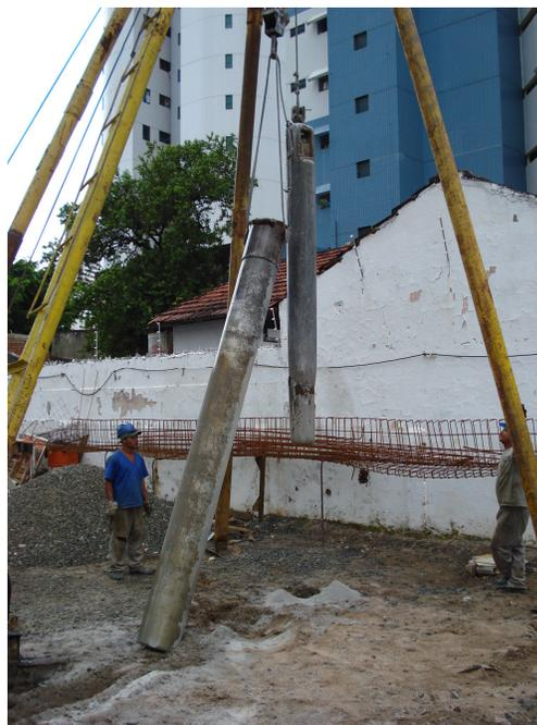
**Figura 3.43** – Posicionamento do tubo.
