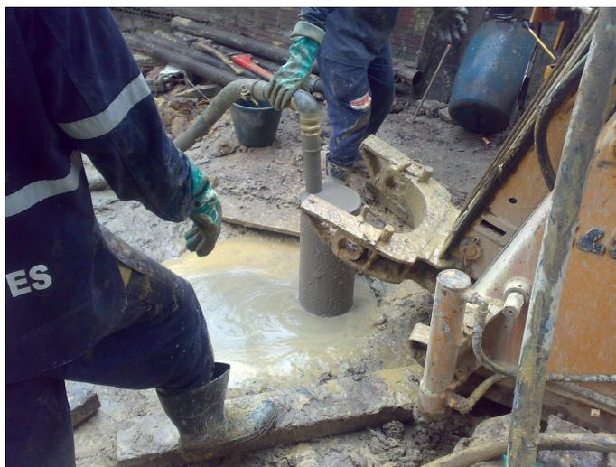
**Figura 3.57** – Preenchimento do tubo com argamassa.
