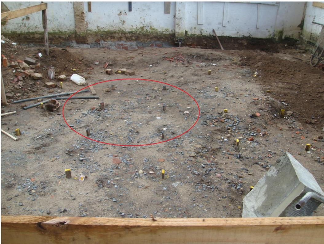
**Figura 3.46** – Estacas executadas de RCD (preto) e convencionais (amarelo).
