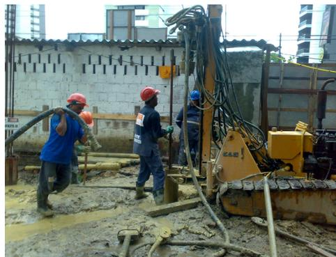
**Figura 3.59** – Inserção da barra no tubo.
