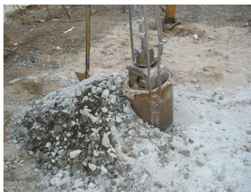
**Figura 3.45** – Apiloamento do material.
