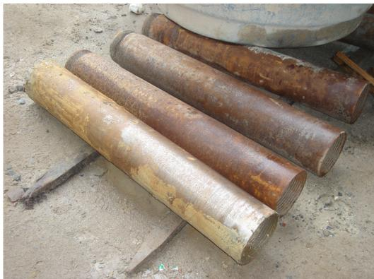
**Figura 3.55** – Tubos empregados na execução de estacas raiz.
