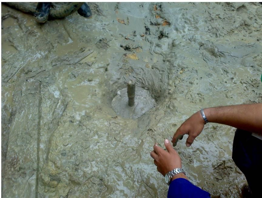
**Figura 3.61** – Aspecto final de uma estaca raiz.
