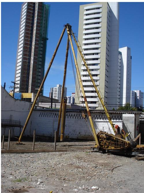
**Figura 3.42** – Bate estacas tipo tripé utilizado na confecção da malha.
