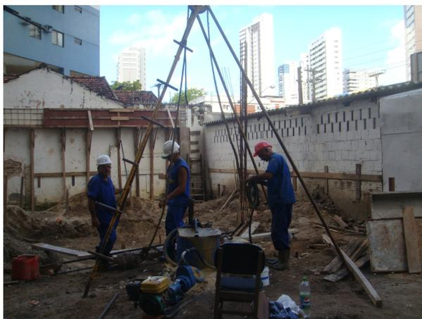
**Figura 3.53** – Tripé montado para execução do ensaio.
