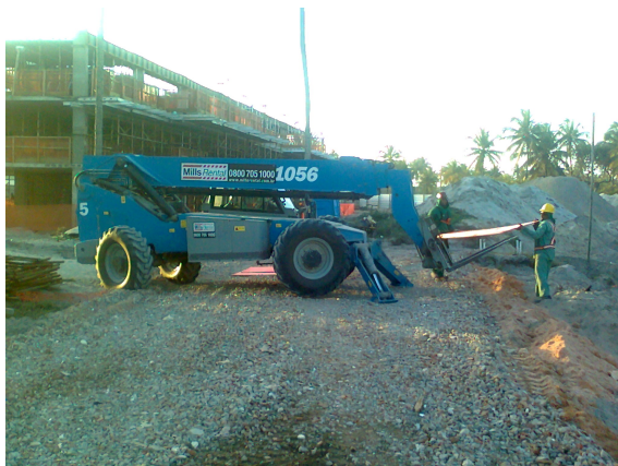
Figura 5.29: Manipulador telescópico utilizado para transporte interno
