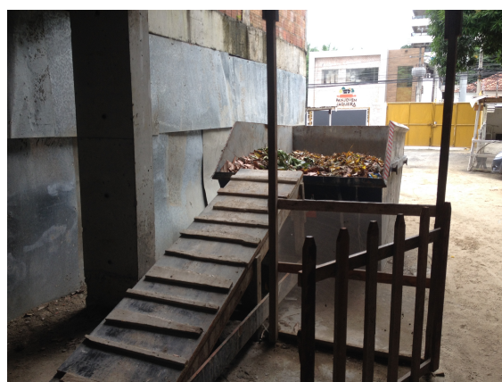
Figura 5.28: Caçamba coletora acessível com escada em madeira
