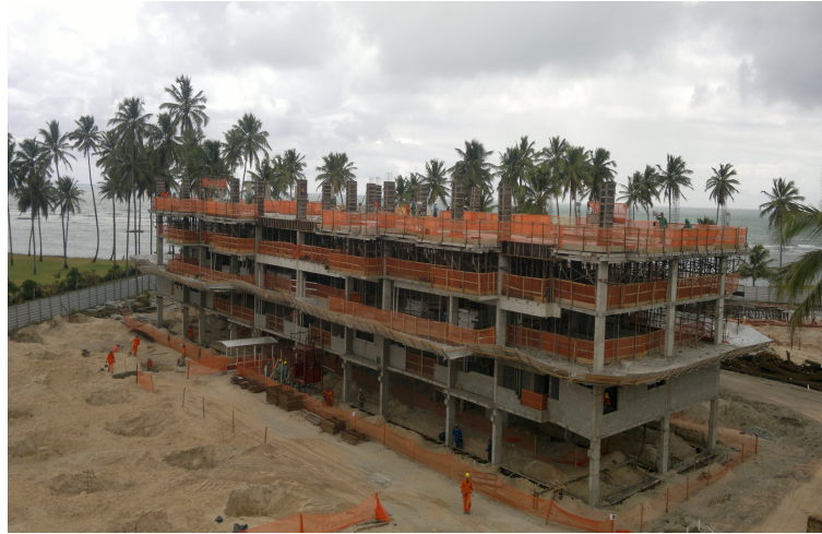
Figura 5.4: Obra de nº 23 – Fase de estrutura com concretagem de lajes
