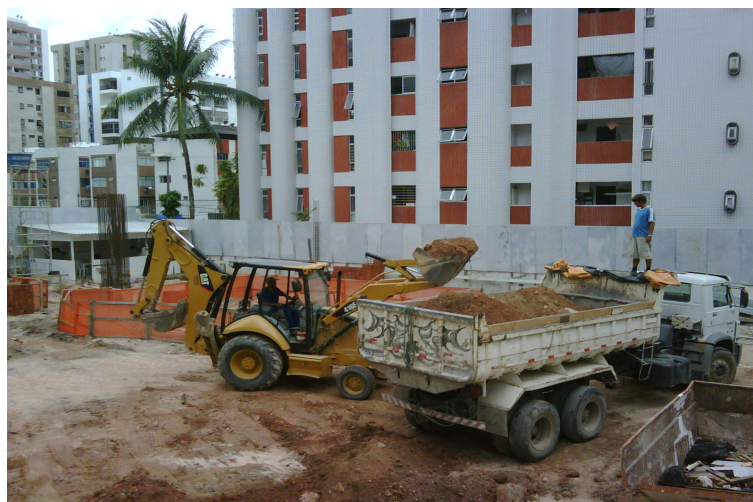
Figura 5.13: Remoção de materiais proveniente de escavações – obra nº 39
