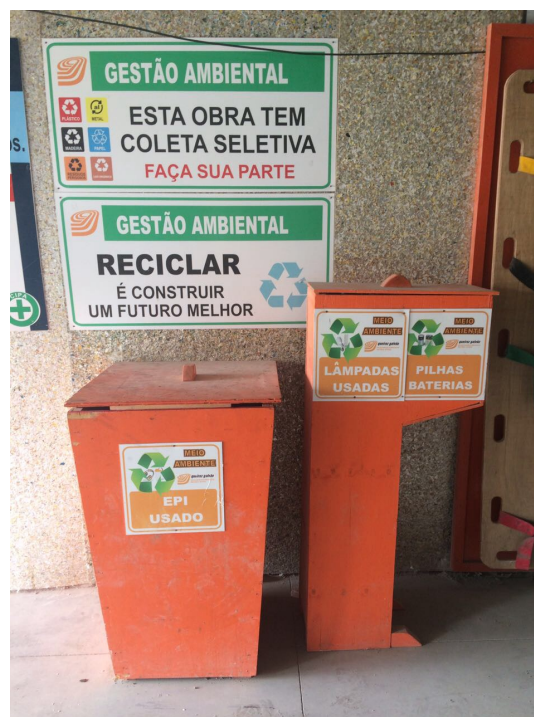
Figura 5.24: Dispositivos para guarda de EPI e lâmpadas usadas – obra 49
