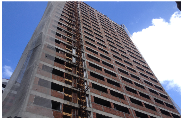
Figura 5.5: Obra de nº 36 – Fase de acabamento com revestimentos de fachadas
