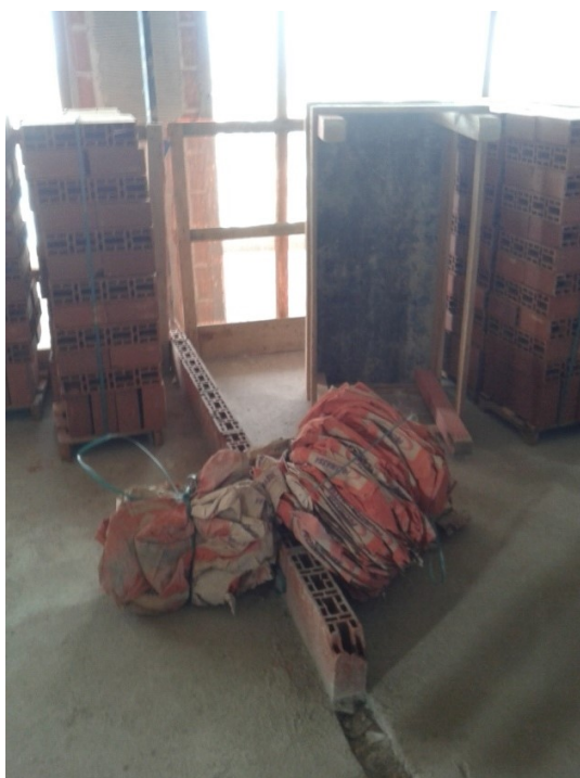
Figura 5.23: Embalagens de argamassa para acondicionamento – obra 46
