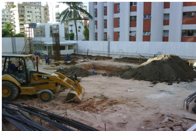
Figura 5.12: Escavação dos blocos de fundação – obra nº 39
