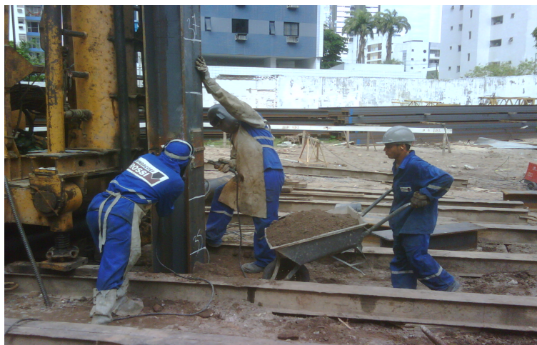
Figura 5.2: Obra de nº 33 – Fundação em estaca metálica em perfil "I"
