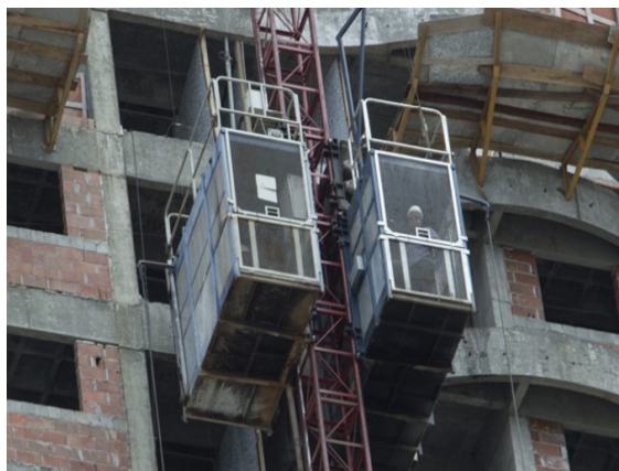
Figura 5.30: Guinchos cremalheiras utilizados para transporte vertical
