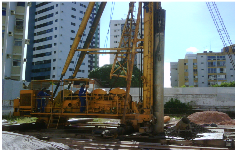
Figura 5.1: Obra de nº 32 – Fundação em estaca Franki com compactação profunda
