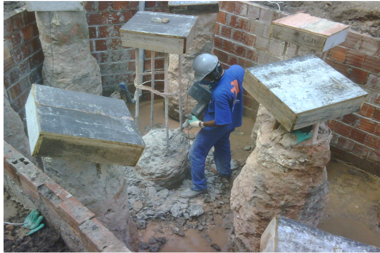
Figura 5.14: Arrasamento de estacas de concreto – obra nº 39
