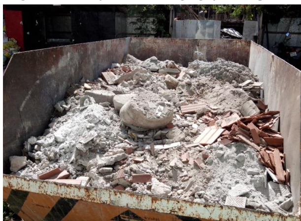
Figura 4.3 – Caçamba com segregação adequada.
