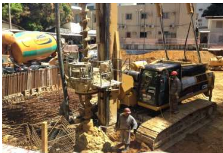
Figura 16: Execução de estaca tipo hélice contínua na obra.
