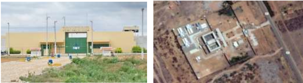
Figura 2 – Conjunto Penal de Juazeiro
